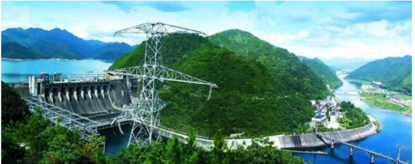
Central hidroeléctrica de Xin'anjiang. Col. industrytap.com
