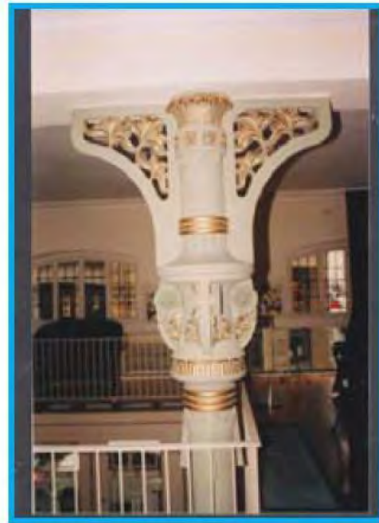
Lámina 19. Detalle de las columnas de fundición interiores. A.M.Z.
