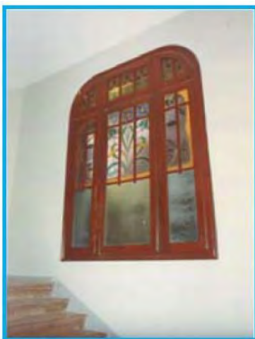
Lámina 18. Detalle de las vidrieras interiores ubicadas en la caja de escaleras. A.M.Z.
