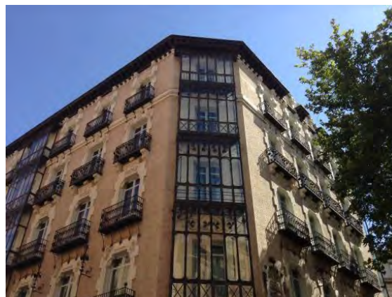
Lámina 10. Edificio calle Manifestación, 16. Col. privada.
