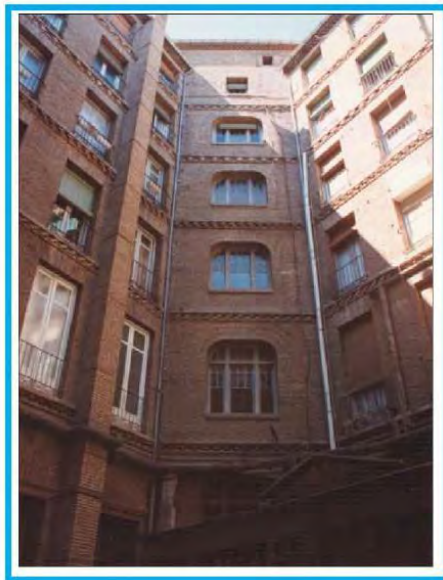
Lámina 15. Vista del patio interior del inmueble. A.M.Z.
