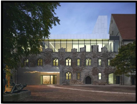
Vista del acceso al museo desde el patio interior (2010). Col. privada.
