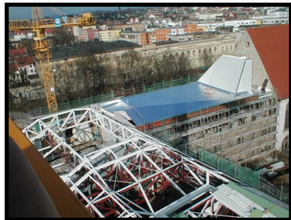
Durante la construcción de la cubierta en 2007.
