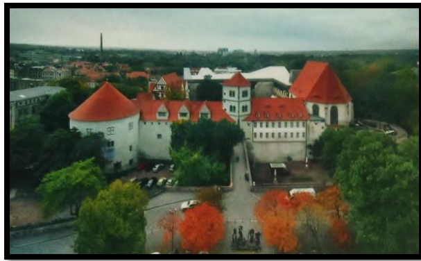
Vista exterior del castillo de Moritzburg.
