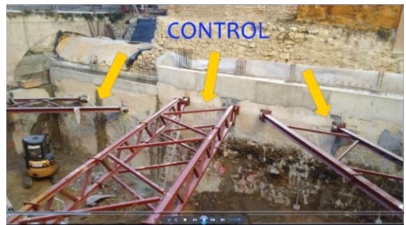
Figura 3. Video Flip-Teaching de control de ejecución de sistemas de contención.
