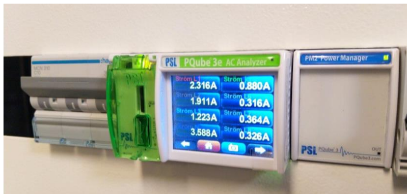
Fig. 15: Power quality meter PQube 3e AC Analyzer
