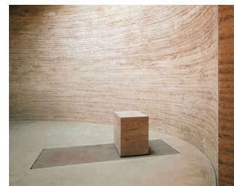
Fig 43. Capilla de la Reconciliación, Berlín. Martin Rauch, construcción del muro en tapial.
