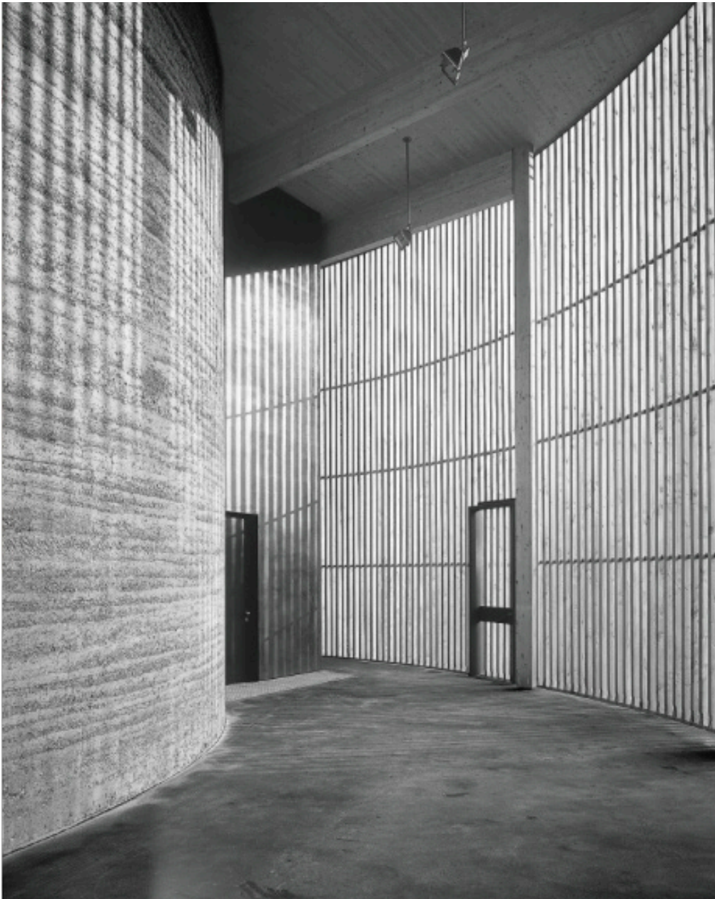
Fig 96. Deambulatorio preambulo del espacio sacro. Contraste entre la ligereza de las lamas de madera en el corredor y el muro masivo sin aberturas de tapial del espacio de culto.
