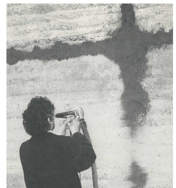
Fig 175, 176, 177, 178. Apilación, transporte, colocación de piezas prefabricadas y disimulado de juntas.
