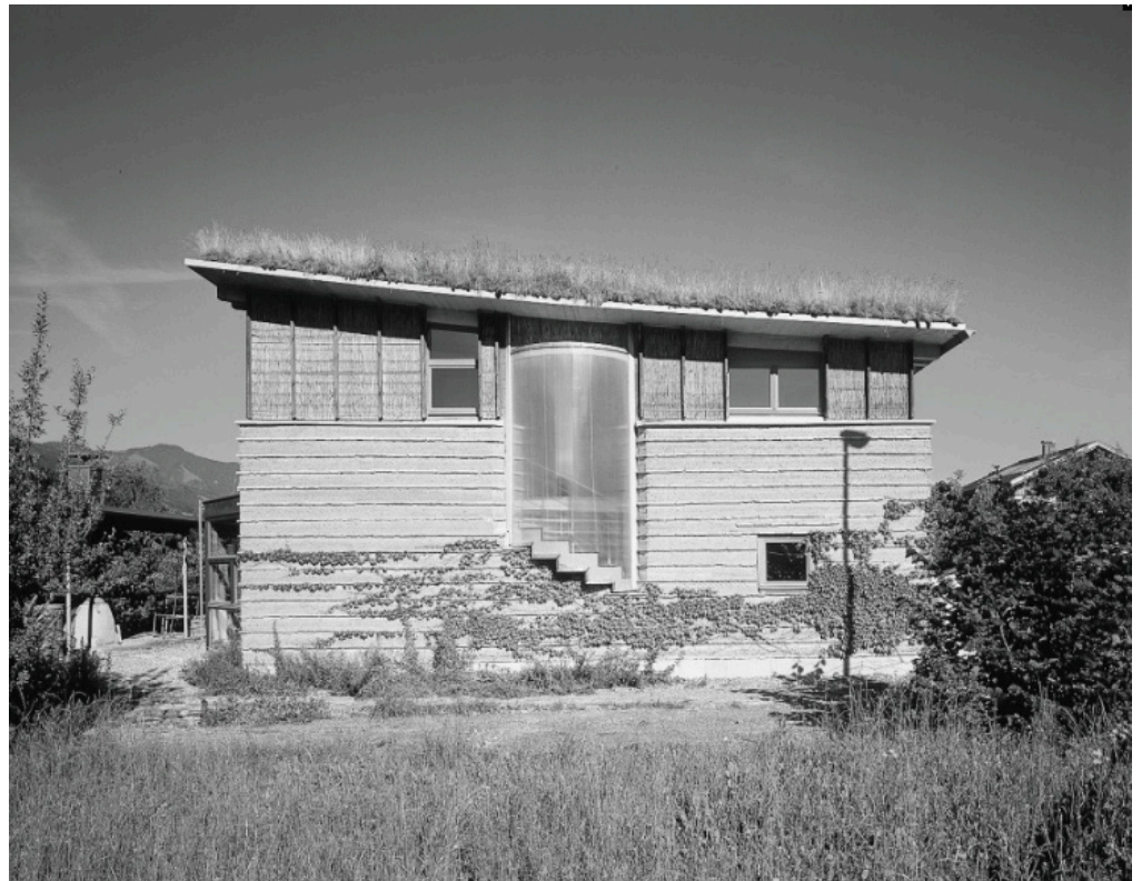
Fig 58. Estudio Rauch. Materialización de la fachada: muro en tapial, franja de adobes recubierto con esteras de caña como aislante y cubierta vegetal.
