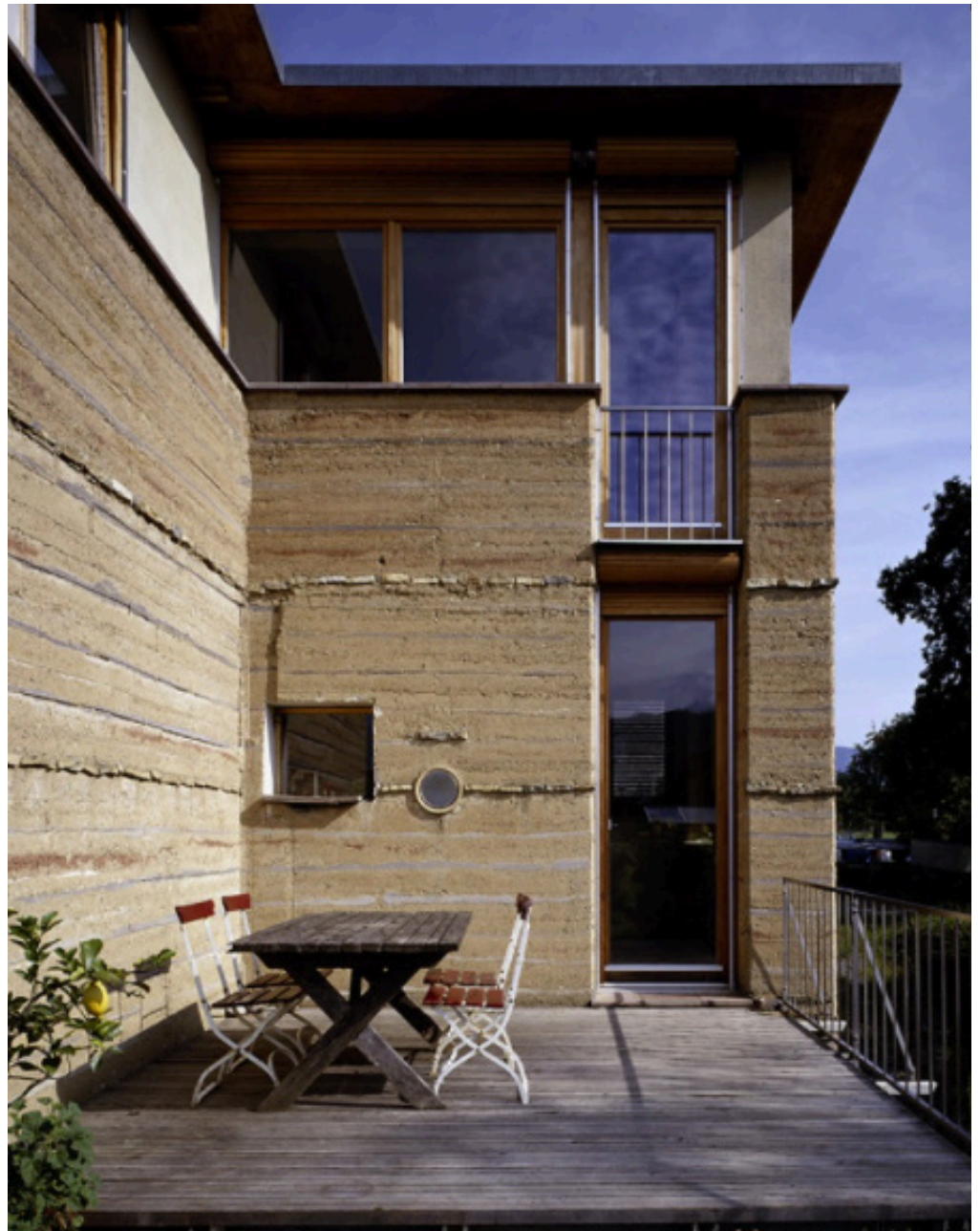
Fig 99. Imagen exterior, terraza Casa Mathies. Bandas alternas de mortero y arcilla para el control de la erosión.
