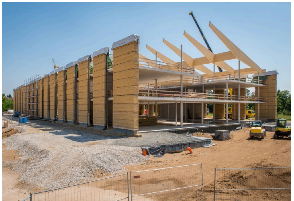
Fig 218, 219. Construcción inicial de la estructura de hormigón armado.
