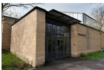
Fig 122. Vista de entrada al zoo. Chapa metálica en voladizo sobre cubierta de hormigón para frenar la erosión.
