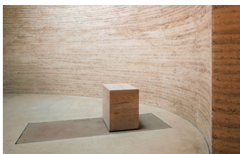
Fig 92. Imágen interior. Muro en tapial y solado de tierra compactada.
