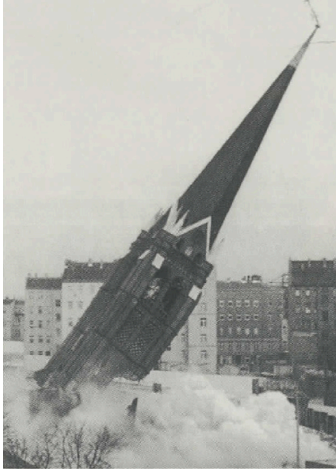
Fig 75. La antigua iglesia había sido inaccesible desde 1961 cuando la ciudad se dividió, hasta 1985 que fue derrumbada.
