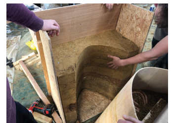
Fig 234. Compactación y desencofrado.
