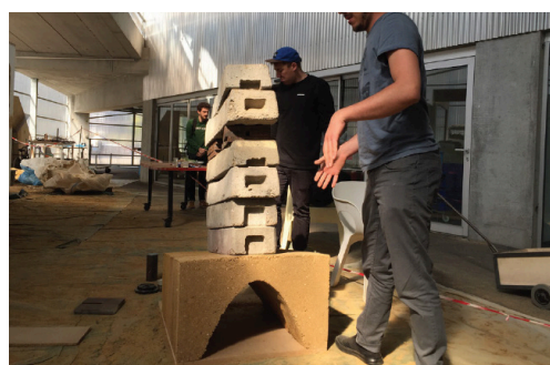
Fig 42. Muro en tapial realizado en tres fases.
