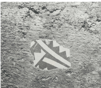
Fig 77. Muro en tapial: reminiscencias de la antigua iglesia.
