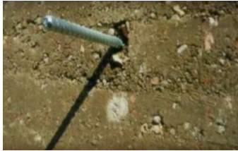
Fig 90. Refuerzos en el interior del muro.
