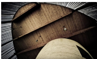
Fig 93. Estructura de vigas de madera en cubierta.
