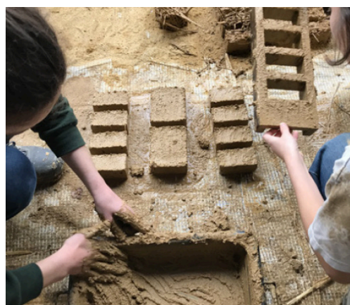
Fig 28. Relleno de la mezcla en los moldes previamente mojados con agua.
