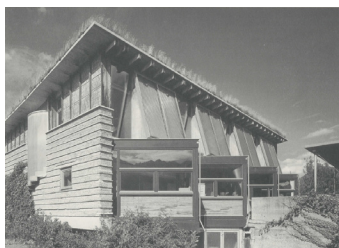
Fig 66. Estructura de vidrio y madera, Estudio Rauch.
