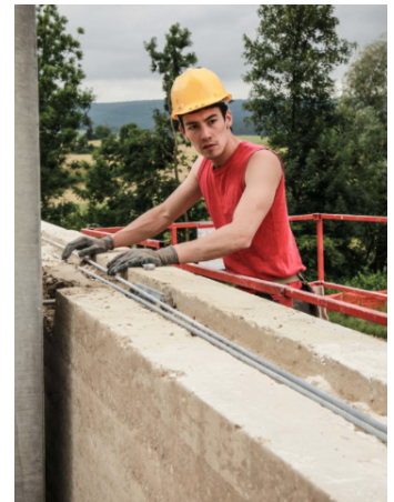
195. Arriostramiento horizontal con cables de acero.
