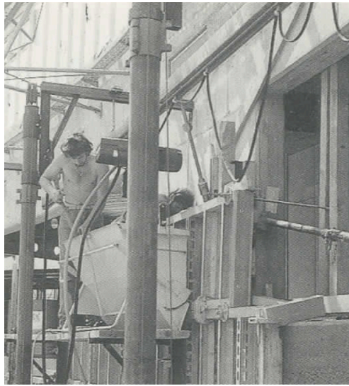
Fig 68, 69, 70, 71. Proceso de construcción del tapial adosado a un muro de hormigón. Es necesario que pueda estar dentro de la tapiera una persona con un apisonador neumático, por lo que el encofrado se realiza por fases en altura dependiendo de esto.
