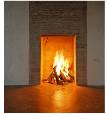
Fig 161. Chimenea en tapial Casa Rauch.
