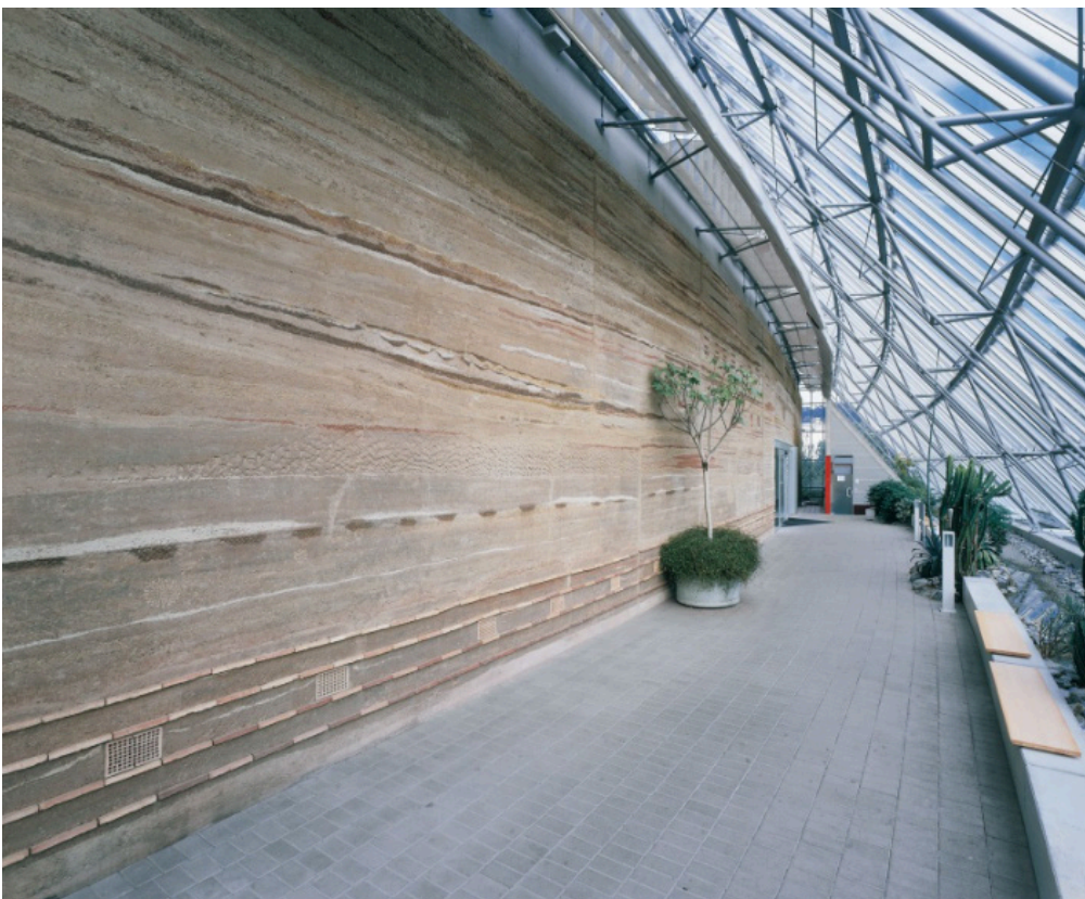
Fig 67. Hospital LFH Feldkirch. Rendijas de ventilación en su parte inferior.
