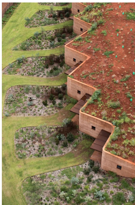
Fig 7. Ejemplo de rehabilitación de una vivienda construida en tierra. Bretaña, Francia.
