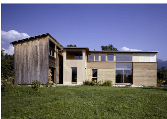
Fig 98. Casa M en muros de tapial. Carpinterías de madera en consonancia con el graje y el almacén. Constraste de la casa realizada en estratos horizontales con la fachada de madera vertical del garaje.
