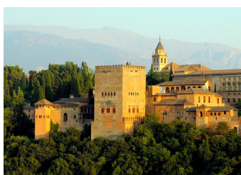
Fig 3. Alhambra de Granada, España. Construcción en tapial del siglo IX 5 .
