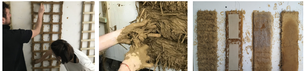
Fig 31. Aplicación de una fina capa de tierra en la estructura que sirva de agarre.
