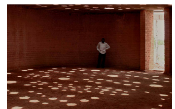
Fig 30. Biblioteca en Gando, Burkina Faso. Francis Kéré. Construcción de muros con adobes.
