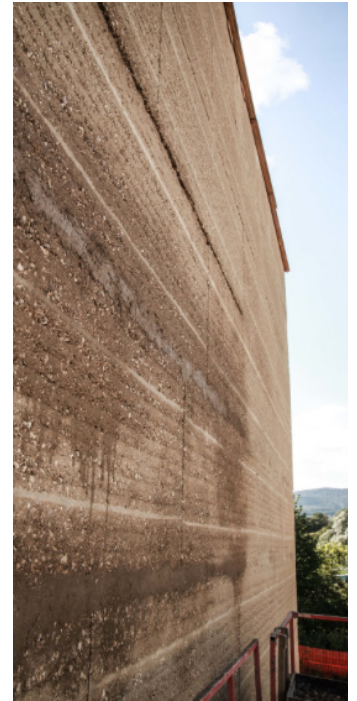
Fig 202. Mojado de la pared para conseguir una estructura homogénea.
