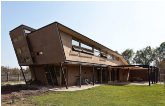
Fig 36. Casa Munita González, Batuco, Chile. Subestructura metálica y relleno de tierra aligerada con paja. Arias Arquitectos + Surtierra Arquitectura.
