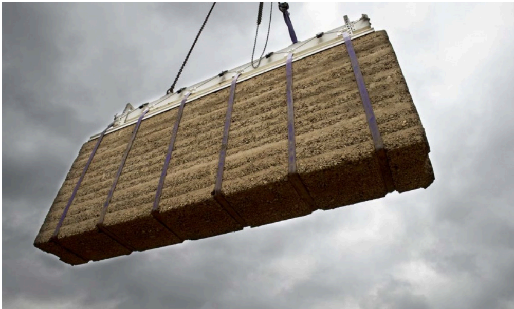
Fig 194. Resolución de juntas verticales con mortero de toba volcánica y cal. Juntas horizontales con mortero de arcilla sobre cableado embebido en mortero de toba y cal.
