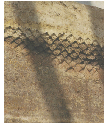
Fig 72. Exploración en la textura del tapial. Contraste con el muro de hormigón en segundo plano.
