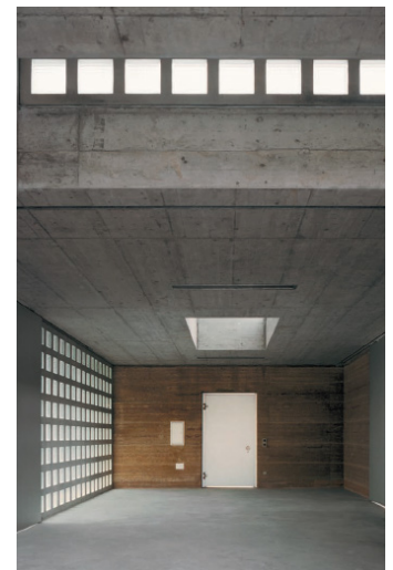
Fig 127. Interior almacén norte.
