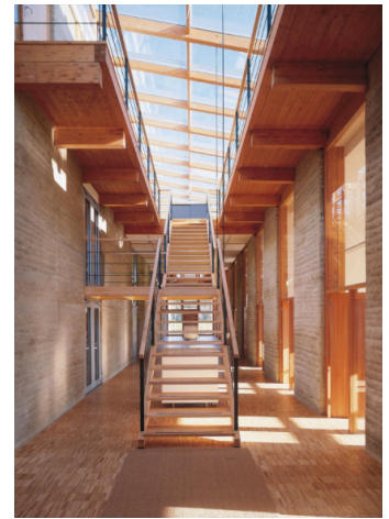
Fig 174. Atrio central de la empresa. Estructura de bloques de tapial con el sistema de aclimatación integrado .
