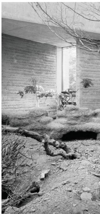
Fig 115. Interior Zoológico de Basilea. Tapial como un elemento natural más del zoo. Cubierta masiva de hormigón.
