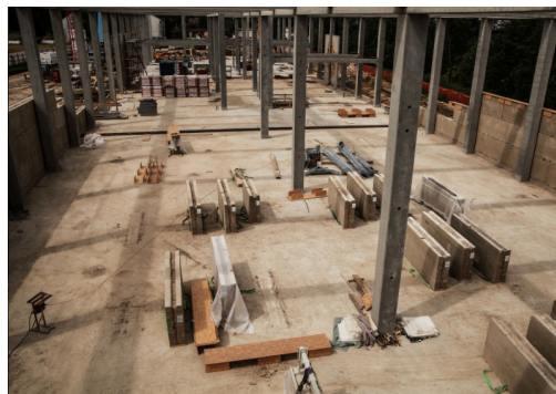
Fig 196, 197. Estructura de pilares prefabricados de hormigón.
