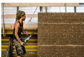
Fig 52. Prefabricación de tapial, Fábrica Rícola.
