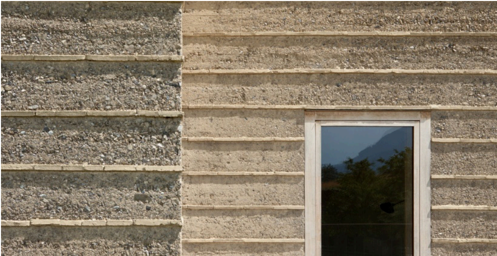
Fig 160. Control de erosión con piezas cerámicas. Ritmo creciente en su parte superior.
