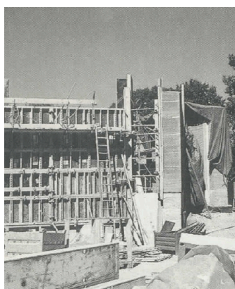
Fig 119, 120, 121. Construcción de los muros en tapial. Vertido de la tierra. Compactación mecánica. Encofrado en fases por alturas.
