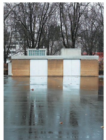
Fig 128. Exterior almacén sur.
