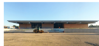
Fig 44. Museo de Narbona. Actualmente en construcción con bloques prefabricados de tapial. Foster + Partners.
