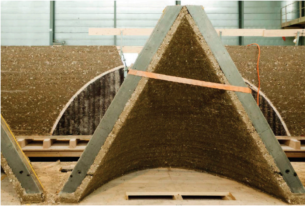
Fig 230. Construcción en taller y preparación de piezas para su transporte.
