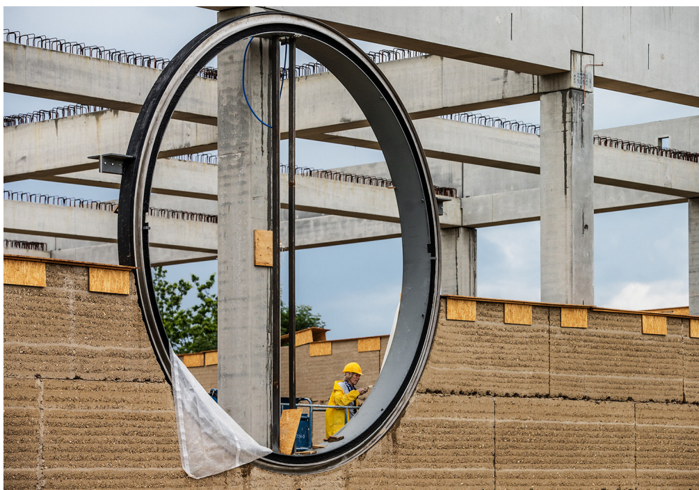
Fig 210. Axonometrica constructiva. No se necesita un refuerzo extra como dintel circular puesto que las fuerzas se distribuyen como en un arco de medio punto.
