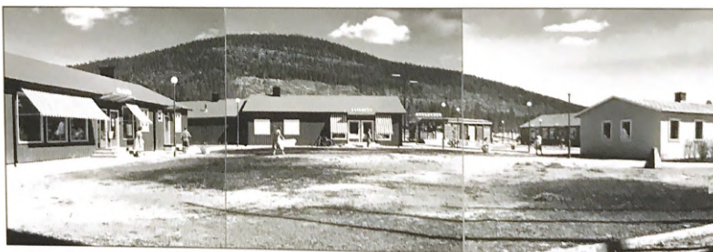
Fig. 20. Fachada principal del Älvgården. Vattenfall, 1958
