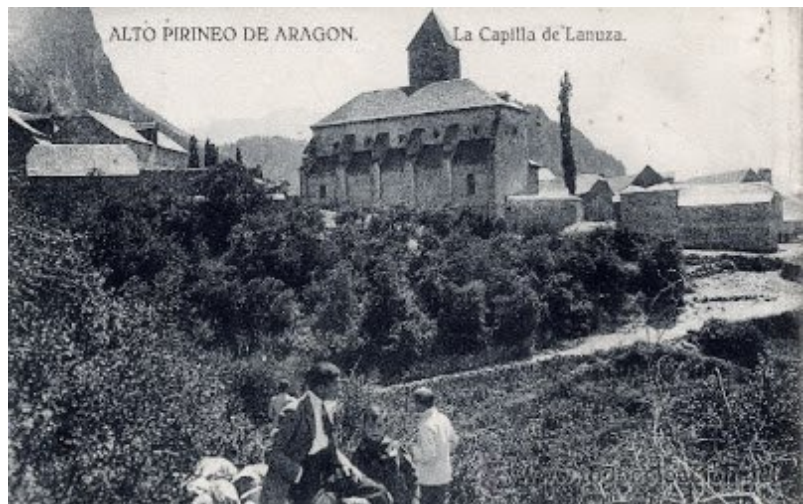
Fig. 47. Vista del valle, aguas abajo. J. Soler, 1904-14. Lanuza aparece en el centro.
