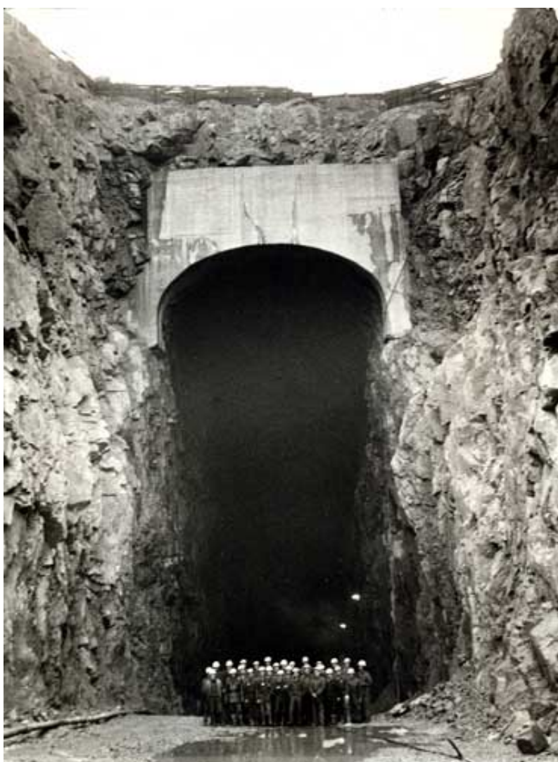
Fig. 13. Fotografía en la boca del túnel de descarga de la presa. H. Skogh, 1955
