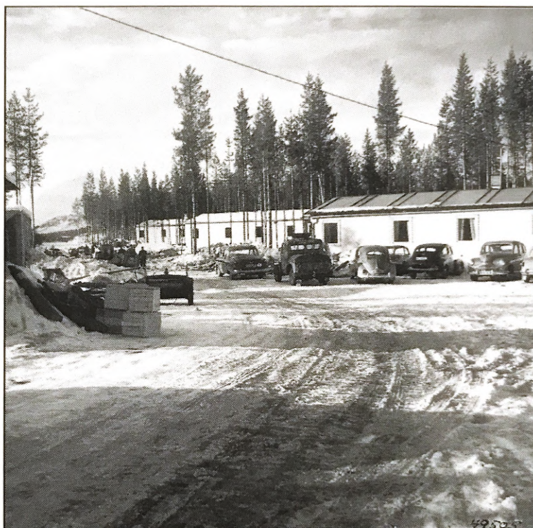
Fig. 16. Montaje de uno de los barracones de solteros. Se puede observar que éstos también siguen un módulo que se repite, al igual que las skivhusen . Vattenfall, 1957
