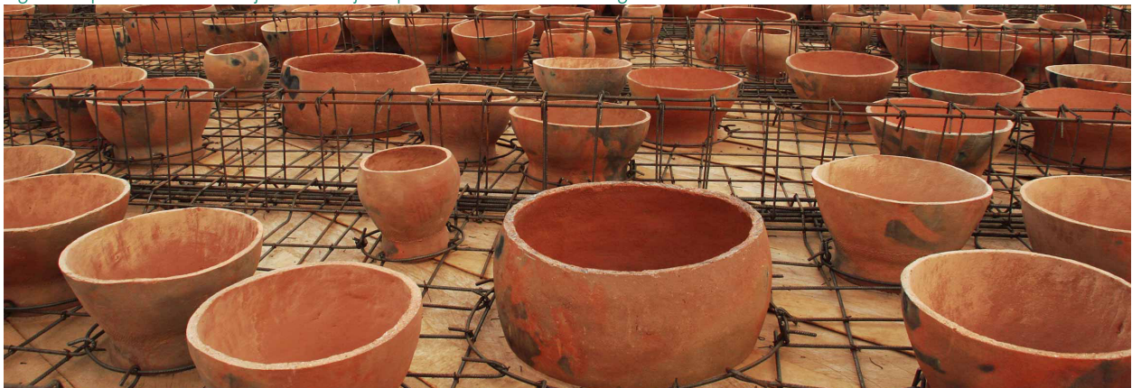
Fig.97 Disposición de las vasijas en el forjado previo al vertido de hormigón .
