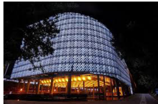
Fig.22 Fachada iluminada por la noche con las luces LEDs introducidas en los Polli-Bricks,
