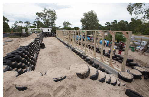
Fig.100 Muro de contención de neumáticos Fig.101 con arena compactada.
