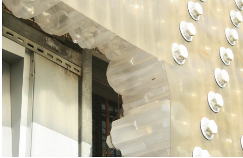
Fig.28 Detalle de la lámina que cubre los Polli-Bricks
