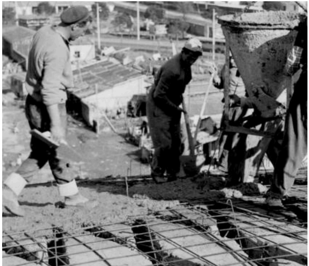
[FIGURA 78] Proceso de hormigonado para el ensamblaje de piezas y acabado en cubierta. Roma, MAXXI, archivo Pier Luigi Nervi.
