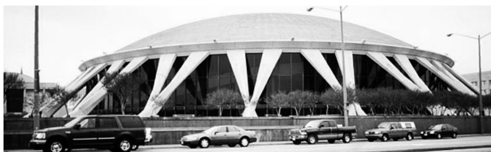
[FIGURA 86-87] Despiece de la cubierta en piezas prefabricadas con formas triangulares y resultado final del Cultural and Convention Center en Norfolk (1965-1971).
