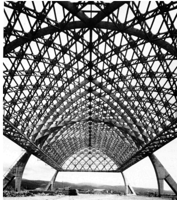
[FIGURA 19] Hangar realizado a base de elementos prefabricados, segunda serie, Orvieto, Torre del Lago, 1939-1942. Roma, MAXXI, Archivo Pier Luigi Nervi
