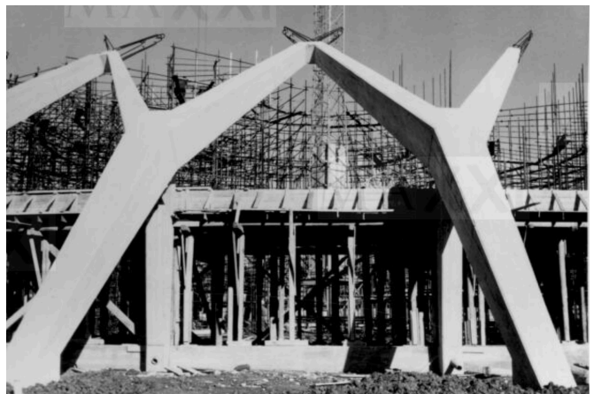
[FIGURA 64] Proceso de colocación del sistema de andamios de la cúpula. Roma, MAXXI, archivo Pier Luigi Nervi.
