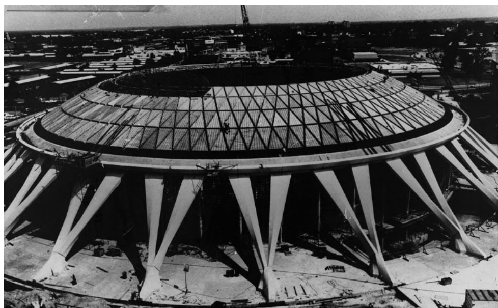
[FIGURA 84-85] Despiece de la cubierta en piezas prefabricadas con formas romboidales y resultado final del Palazzetto de los Deportes en Roma (1956-1957). Roma, MAXXI, archivo Pier Luigi Nervi.
