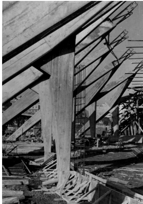
[FIGURA 58] Proceso de colocación del encofrado de los pilares inclinados sobre un sistema de andamios provisional. Roma, MAXXI, archivo Pier Luigi Nervi.
