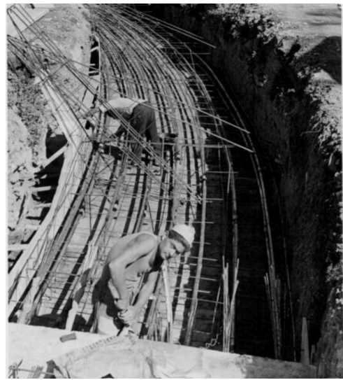
[FIGURA 53] Replanteo, excavación y preparación del anillo de cimentación exterior. Roma, MAXXI, archivo Pier Luigi Nervi.
