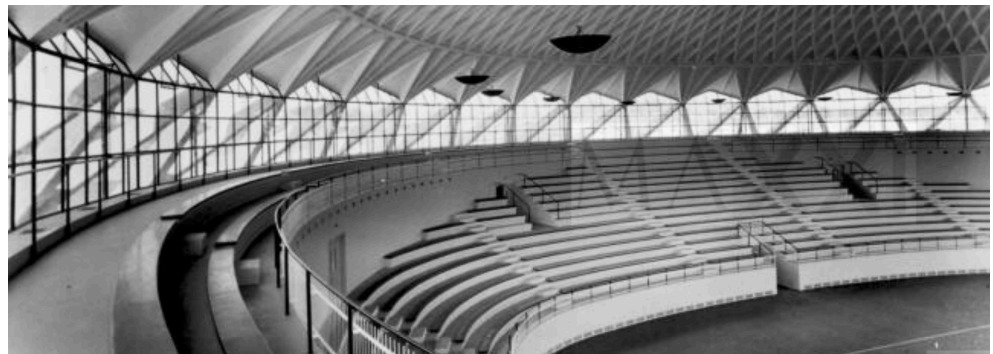
[FIGURA 26] Distribución interior del Palazzetto con el sistema de ventanas perimetrales que permiten el acceso de luz natural al interior. Roma, MAXXI, archivo Pier Luigi Nervi.
