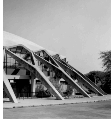
[FIGURA 44] Proceso de unión de los pilares con la cubierta mediante un sistema de anclaje en abanico curvo. Cada uno de ellos absorbe 1/36 del empuje total de la cúpula para posteriormente transmitirlo a cada pilar en "Y". Roma, MAXXI, archivo Pier Luigi Nervi.
