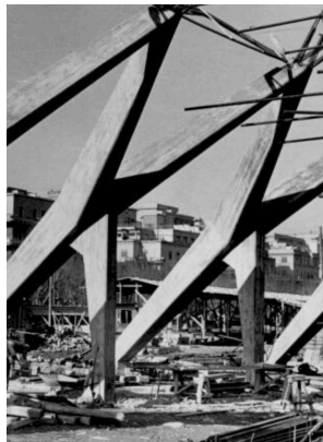
[FIGURA 43] Proceso de construcción de los soportes. Roma, MAXXI, archivo Pier Luigi Nervi.
