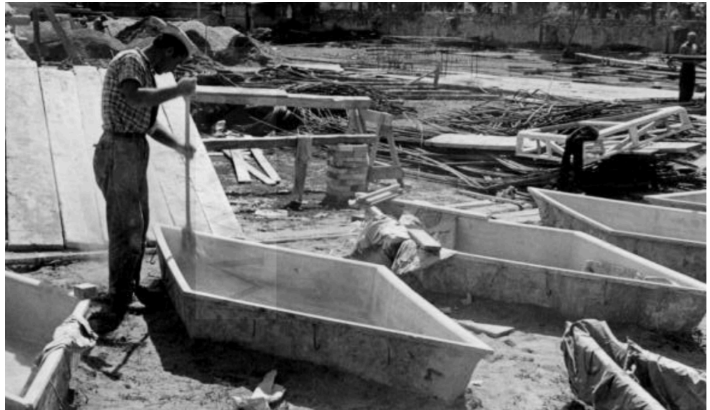
[FIGURA 74] Resultado final de una de las piezas prefabricadas. Roma, MAXXI, archivo Pier Luigi Nervi.
