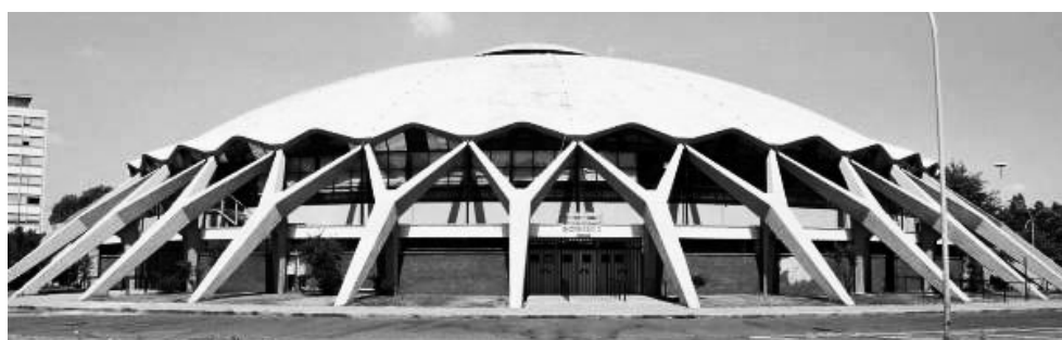
[FIGURA 84-85] Despiece de la cubierta en piezas prefabricadas con formas romboidales y resultado final del Palazzetto de los Deportes en Roma (1956-1957). Roma, MAXXI, archivo Pier Luigi Nervi.
