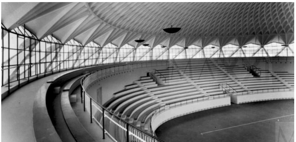
[FIGURA 81] Recubrimiento y unificación de la cubierta con una ligera capa de cemento. Roma,MAXXI, archivo Pier Luigi Nervi.
