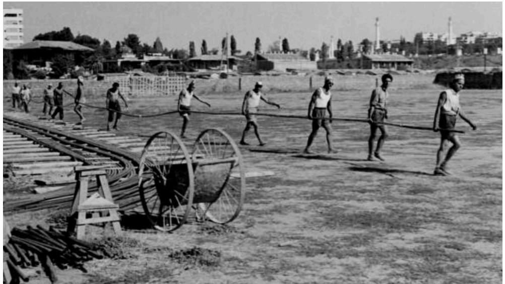
[FIGURA 49] Proceso de almacenaje y transporte de los cables de acero utilizados en el interior de la cimentación. MAXXI, archivo Pier Luigi Nervi.
