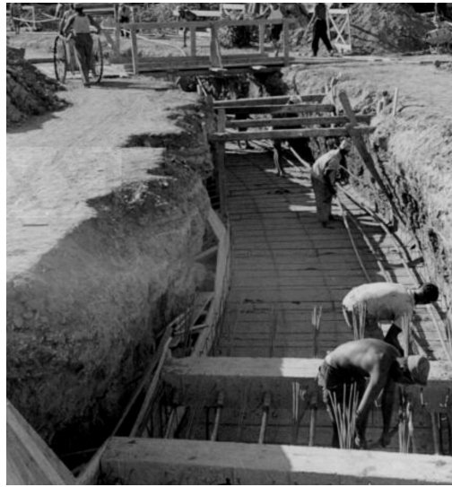
[FIGURA 53] Replanteo, excavación y preparación del anillo de cimentación exterior. Roma, MAXXI, archivo Pier Luigi Nervi.
