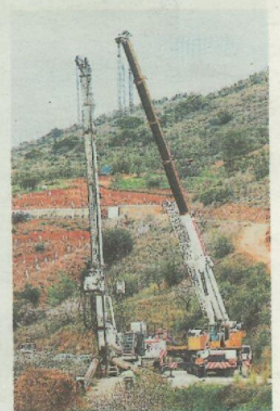
Una máquina en la boca del túnel
