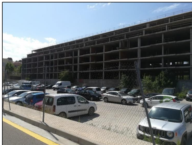
Imagen 11. Aparcamiento provisional y esqueleto de una edificación residencia Fuente propia 09/06/2019
