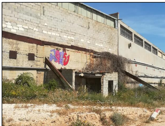
Imagen 2. Naves industriales abandonadas
