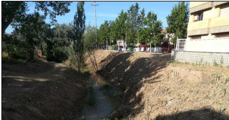
Imagen 5. Vista de las dos márgenes desde el puente de la Avda. Constitución, tramo 1 Fuente propia. 06/06/2019
