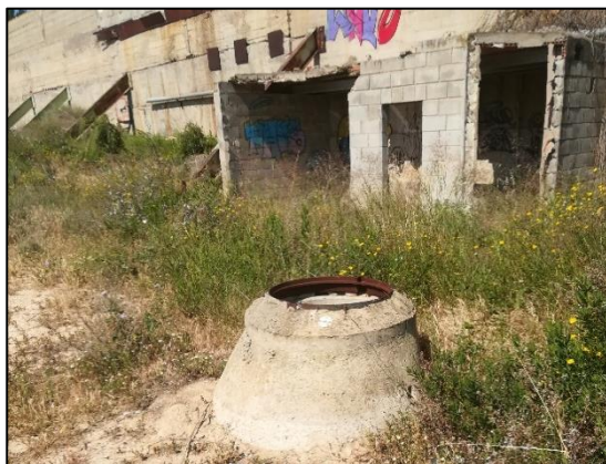
Imagen 3. Acceso al colector
