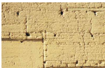
Fig 13 Tapia de tierra. Fuente: Arquitectura de tierra, Caracterización de los tipos edificatorios (Beatriz Yuste, 2010)
