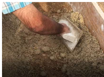
Fig 32 Ejecución de la costra de mortero de cal y cáñamo. Fuente: Documentación gráfica de la empresa Elecnor.
