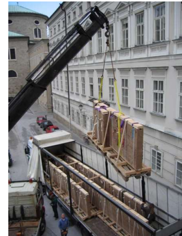
Fig 79 Manipulación módulos de tapial en obra. Fuente: www.lehmtonerde.at
