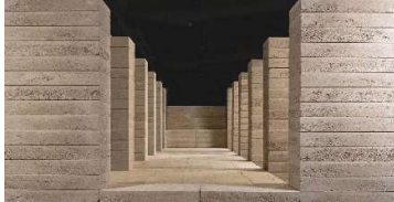
Fig 113 Muros de TapialBlock. Fuente: Catálogo Fetdeterra
