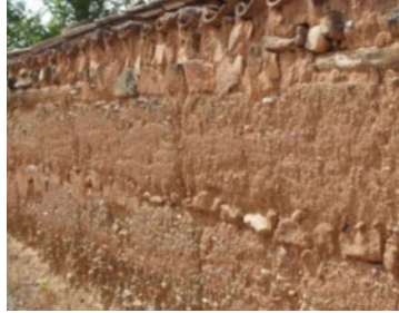
Fig 80 Tapia con refuerzos en lechos con verdugadas de piedra. Fuente: www.restapia.es
