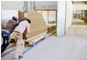
Fig 89 Desplazamiento de los paneles en taller. Fuente: www.lehmtonerde.at
