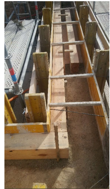
Fig 56 Zuncho de madera. Fuente: Documentación gráfica de la empresa Elecnor.
