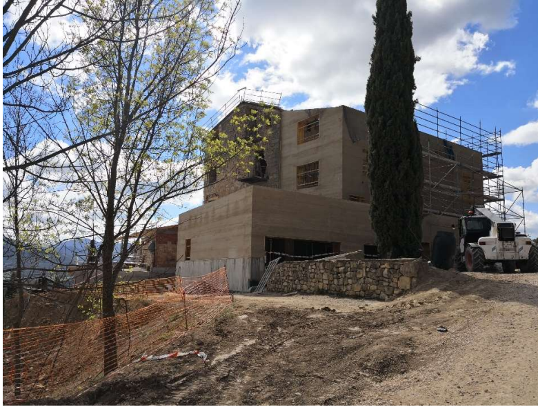
Fig 73 Ampliación de tapia una vez desencofrado todo el muro. Fuente: Documentación gráfica de la empresa Elecnor
