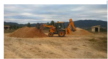
Fig 35 Zona intermedia de mezcla de tierras. Fuente: Documentación gráfica de la empresa Elecnor.
