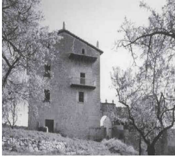
Fig 25 Detalle de la fachada orientada a poniente. Fuente: Documentación gràfica de la empresa Elecnor.
