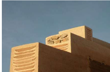
Fig 11 Sección tapia compuesta calicastrada. Fuente: http://ferminfont.blogspot.com
