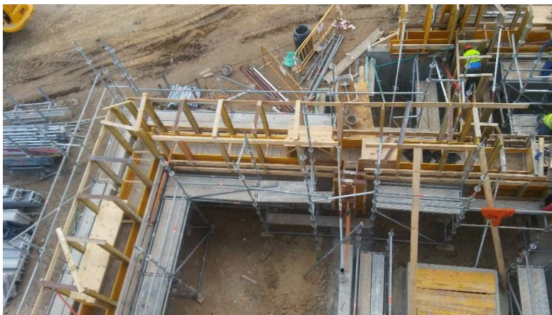
Fig 45 Puesta en obra del muro con tapial. Fuente: Documentación gráfica de la empresa Elecnor.
