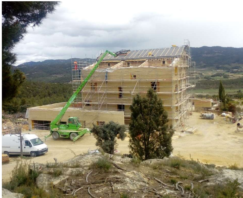
Fig 72 Ampliación de tapia una vez desencofrado todo el muro. Fuente: Documentación gráfica de la empresa Elecnor
