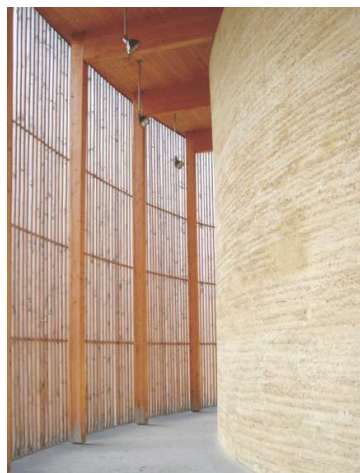
Fig 3 Muros de tapial y estructura de madera en la Capilla de la Reconciliación, Berlín, Alemania. Fuente: Construcción con tierra en el siglo XXI. (S.Bestraten, E.Hormías, A. Altemir, 2011)
