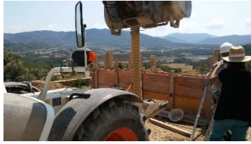
Fig 46 Ejecución de prototipo de tapia. Fuente: Documentación gráfica de la empresa Elecnor.
