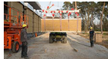
Fig 98 Desplazamiento de los módulos en obra. Fuente: http://www.lehmtonerde.at/de/projekte/projekt.php?PID=97
