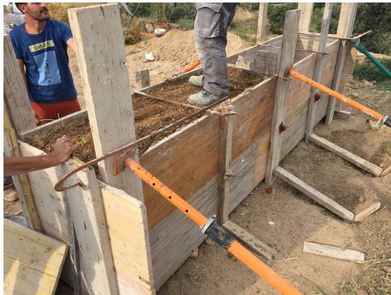
Fig 49 Ejecución de prototipo de tapia. Fuente: Documentación gráfica de la empresa Elecnor.
