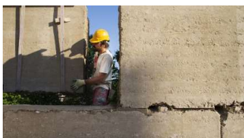
Fig 91 Puesta en obra. Fuente: www.lehmtonerde.at
