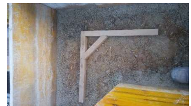
Fig 62 Refuerzo en esquina. Fuente: Documentación gráfica de la empresa Elecnor.
