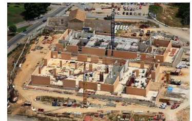
Fig 109 Imagen aérea muros Sirewall. Fuente: https://sirewall.com/project/narbo-via-history-museum-france/
