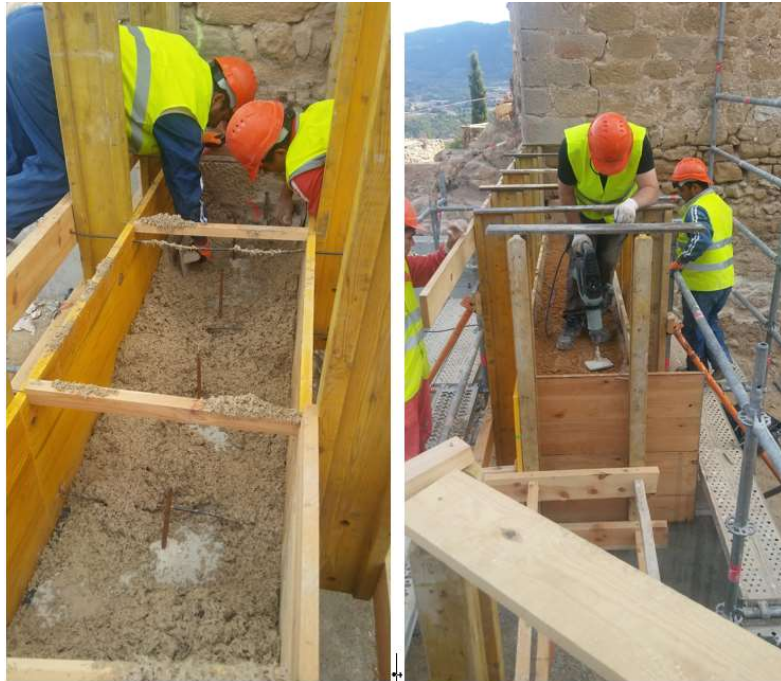
Fig 39 Ejecución del muro de tapial. Ejecución de la costra y seguidamente pisonando de la tierra. Fuente: Documentación gráfica de la empresa Elecnor.
