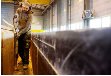
Fig 86 Ejecución de los módulos prefabricados. Fuente: www.lehmtonerde.at
