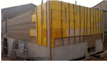
Fig 13 Puesta en obra muro de tapial. Fuente: http://arquitectura.edraculturaynat.ura.com/portfolio-item/casa-de-tapial/
