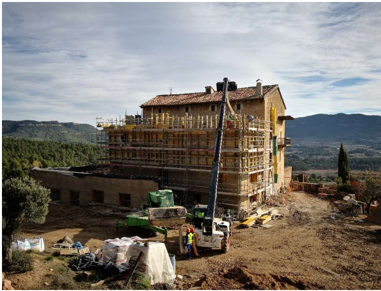
Fig 37 Grúa telescópica elevando las tierras para la ejecución del muro. Fuente: Documentación gráfica de la empresa Elecnor.
