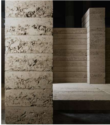
Fig 111 Muros de TapialBlock. Fuente:
