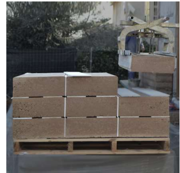
Fig 117 Manipulación de los bloques en obra. Fuente: Fetdeterra
