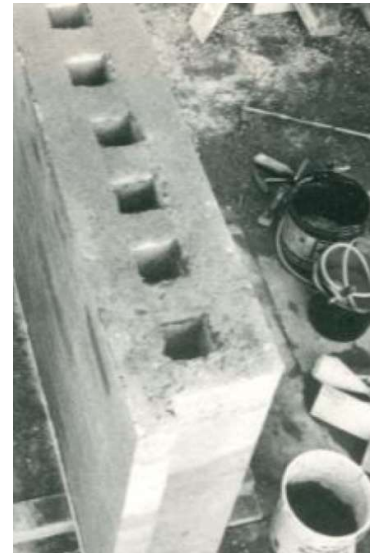
Fig 83 Módulo prefabricado imprenta Gugler. Fuente: "Estudio Comparativo de las Técnicas Contemporáneas en Tierra" Gatti, 2012
