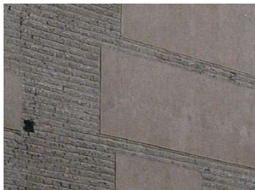
Fig 7 Tapia de Tierra y Machones. Fuente: Arquitectura de tierra, Caracterización de los tipos edificatorios (Beatriz Yuste, 2010)
