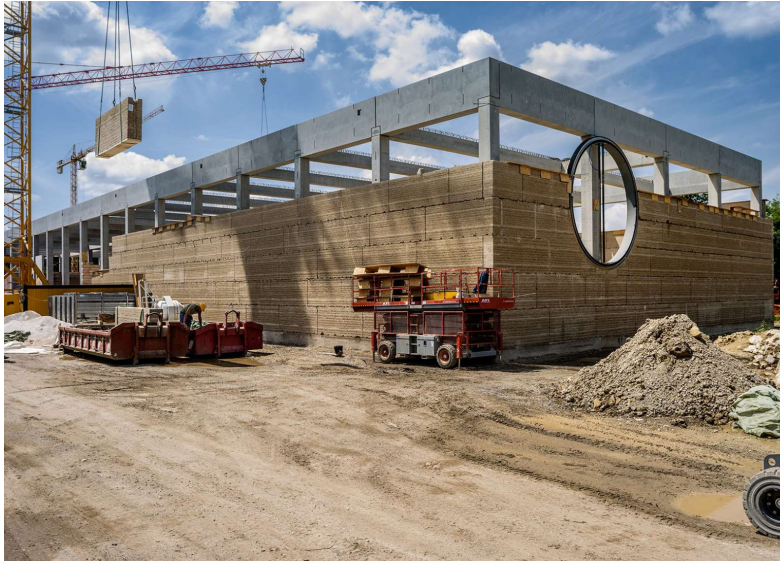
Fig 92 Proceso de montaje de fachada. Almacén de Ricola. Fuente: Iwan Baan
