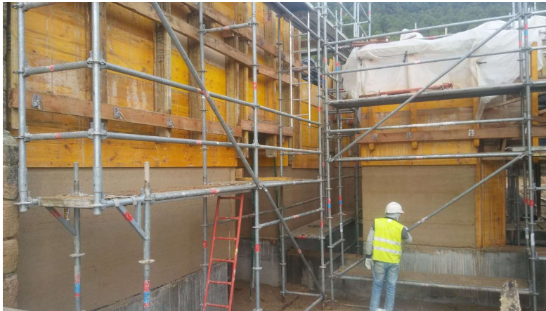
Fig 43 Puesta en obra del muro con tapial. Tapiales desmontados en parte inferior. Fuente: Documentación gráfica de la empresa Elecnor.
