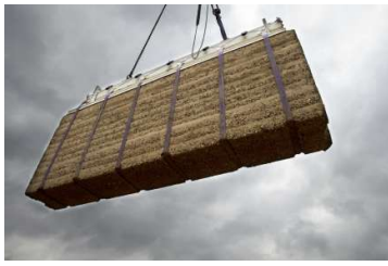
Fig 90. Desplazamiento y sujeción en obra. Fuente: www.lehmtonerde.at
