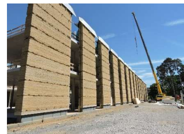
Fig 100 Puesta en obra Alnatura. Fuente: https://zrs-berlin.de/project/rammed-earth-facade-alnatura-welt-darmstadt/
