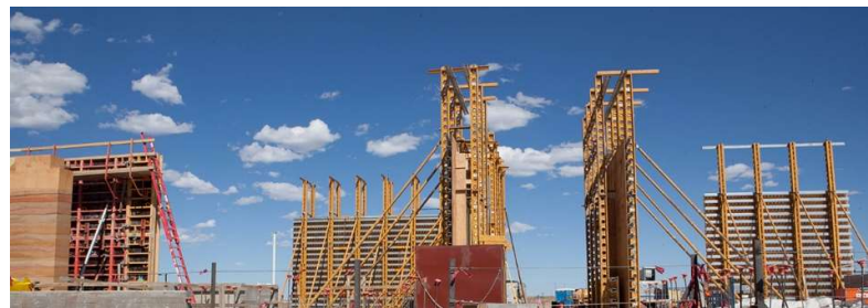
Fig 104 Puesta en obra de los muros SIREWALL. Fuente: https://sirewall.com
