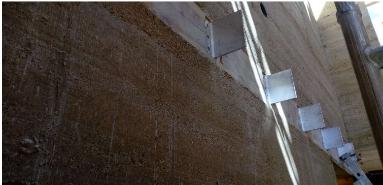
Fig 59 Uniones mecanizadas con las vigas de madera (rotoplast). Fuente: Documentación gráfica de la empresa Elecnor.
