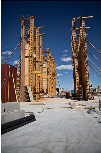
Fig 13 Puesta en obra muro de tapial. Fuente: http://arquitectura.edraculturaynat.ura.com/portfolio-item/casa-de-tapial/
