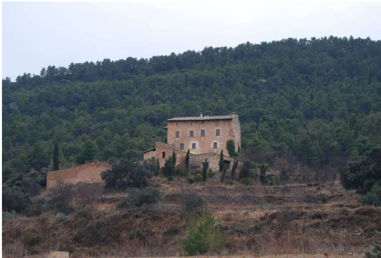
Fig 24 Vista general del conjunto de edificaciones desde el sur este. . Fuente: Documentación gràfica de la empresa Elecnor.
