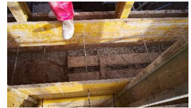
Fig 42 Latiguillos del tapial. Fuente: Documentación gráfica de la empresa Elecnor.
