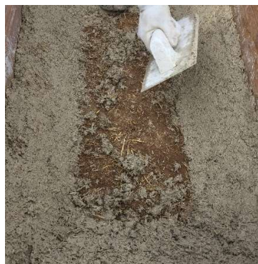
Fig 31 Ejecución de la costra de mortero de cal y cáñamo. Fuente: Documentación gráfica de la empresa Elecnor.
