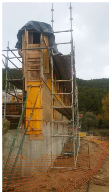
Fig 63 Protección del muro de tapia durante su ejecución por lluvias. Fuente: Documentación gráfica de la empresa Elecnor.
