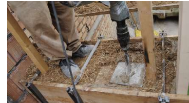
Fig 11 Apisonado entre encofrados de tapial. Fuente: http://terra-award.org
