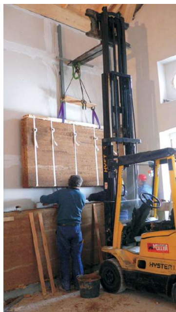
Fig 77 Construcción prefabricada con tapial. Fuente: Paredes de tapial y su industrialización (M. Rauch, 2011)
