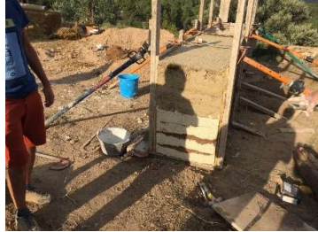
Fig 47 Desencofrado del prototipo de tapia. Fuente: Documentación gráfica de la empresa Elecnor.
