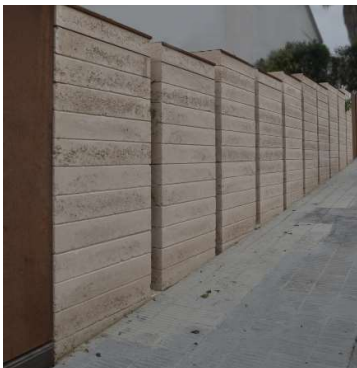
Fig 115 Muro exterior límite de parcela con TapialBlock. Fuente: Fetdeterra
