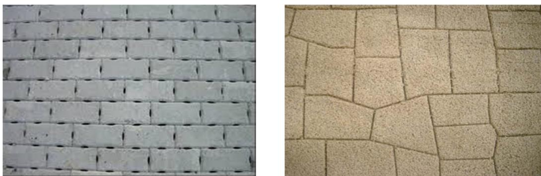
**Ilustración 18. De izquierda a derecha, Pavimentos permeable modular y pavimento permeable continuo.**
