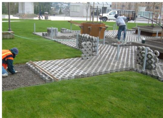
**Ilustración 17. Ejecución de pavimentos permeables modulares**
