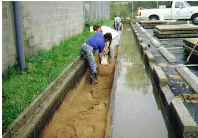
**Ilustración 23. Ejecución de un filtro de arena para reducción de escorrentías y contaminantes**
