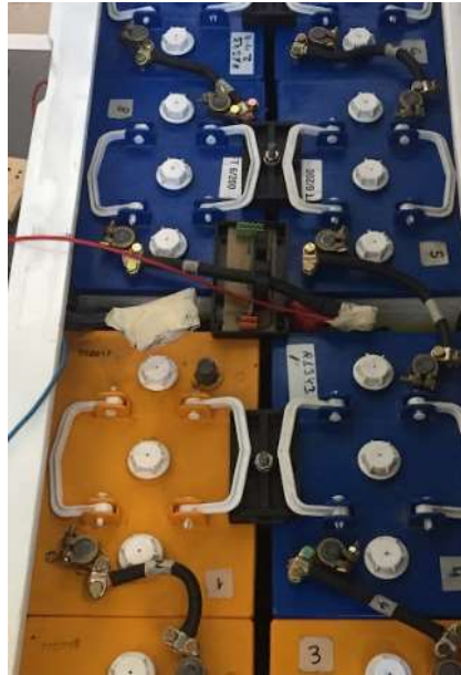
Ilustración 41: Instalación sensor Hall en el Zylog
