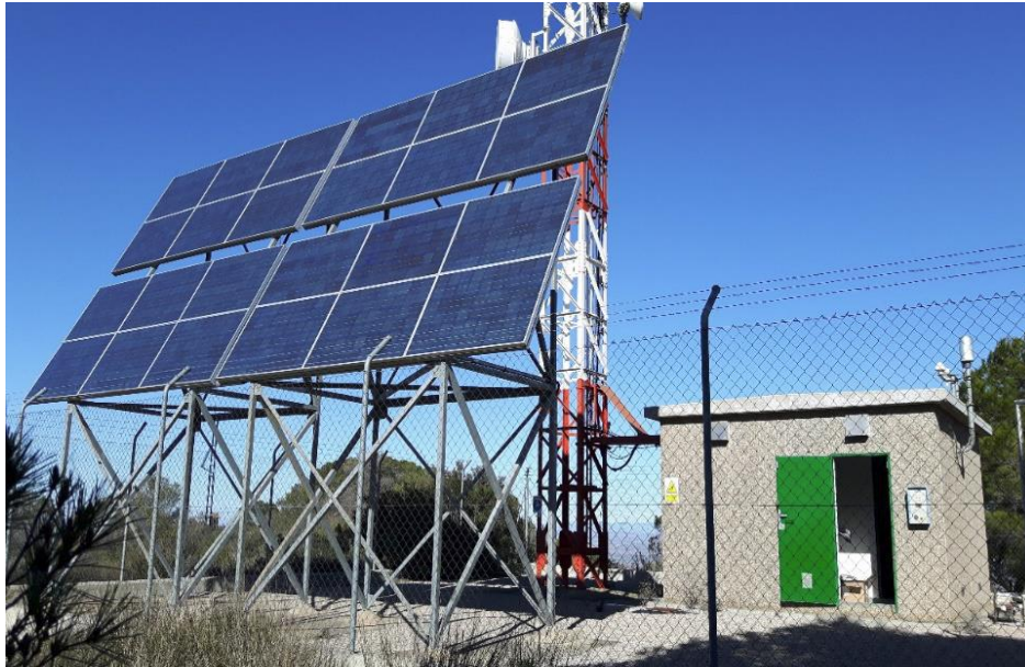
Figura 1.1: Sistema de comunicaciones alimentado por placas fotovoltaicas
