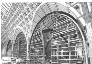
Fig. 96 Fotografía de la construcción de los muros técnicos
