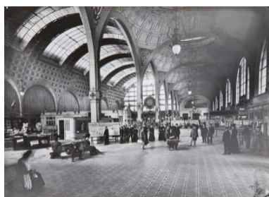
Fig. 15_ Imagen del interior de la estación
