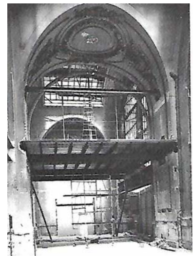
Fig. 93_ Imagen en obra de la creación de un nuevo forjado para los salones ovales
