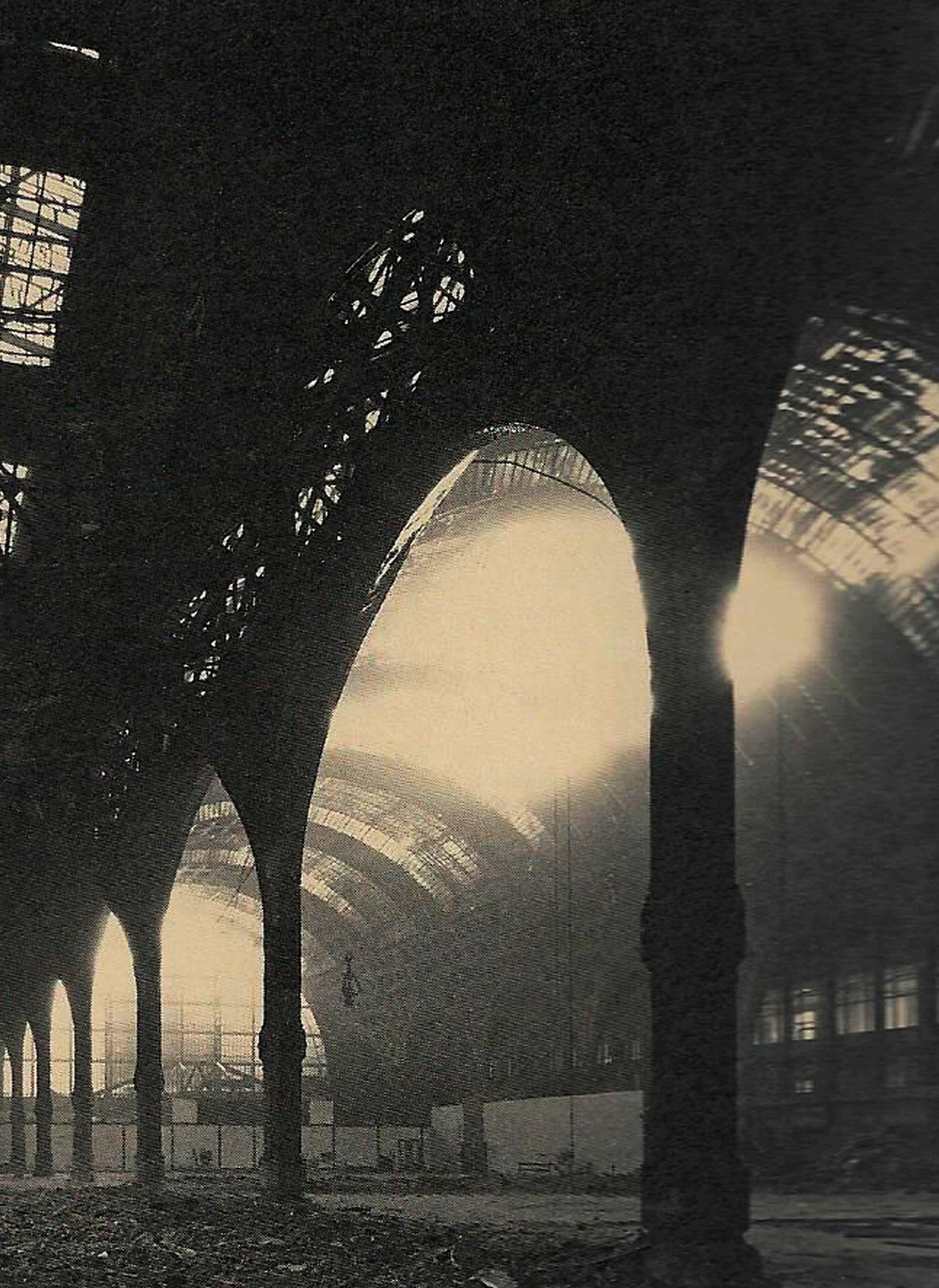
Figura 20_ Imagen del estado previo a la rehabilitación de la estación
