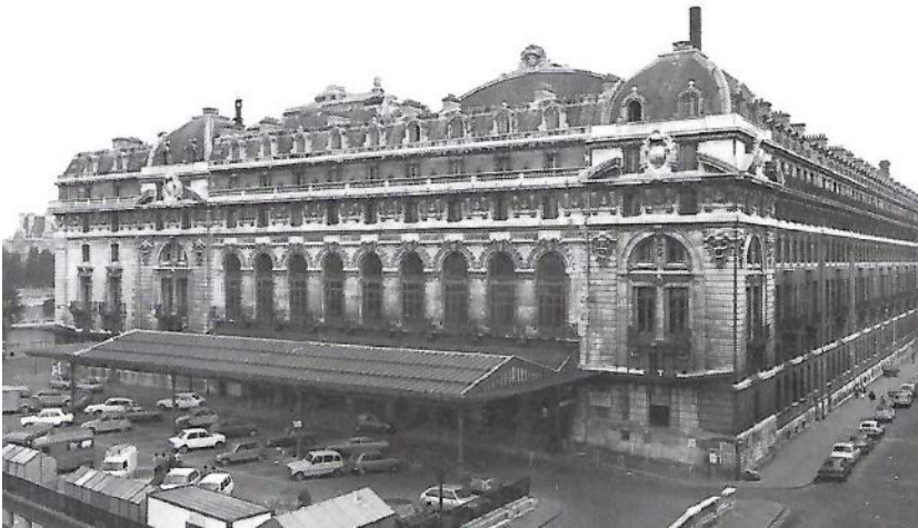
Fig. 12_ Vista de la estación en 1983
