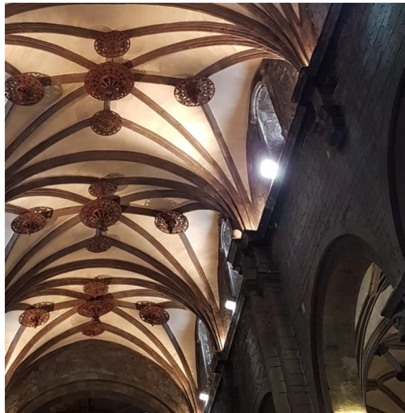
Fig. 32. Detalle de la bóveda central (oportos y lunetos), Juan de Bescós y Bartolomé de Hermosa, 1598-1601
