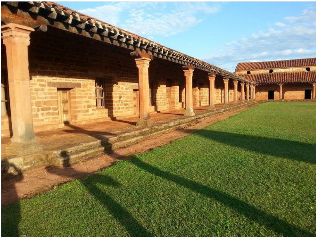
Fig. 16. Soportales en torno a la plaza en el conjunto urbano de la reducción de San Cosme y San Damián (Paraguay).
