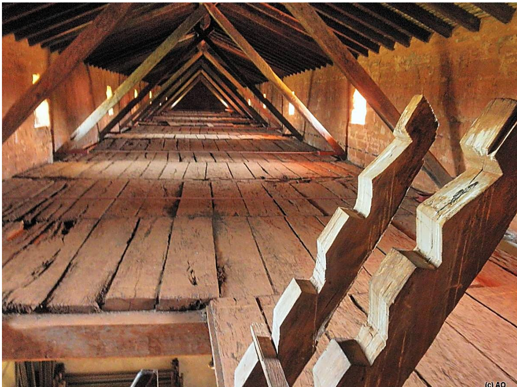
Fig. 22. Entrepiso de madera formado como elemento termorregulador en las casas de los padres de la misión de San Cosme y San Damián (Paraguay)
