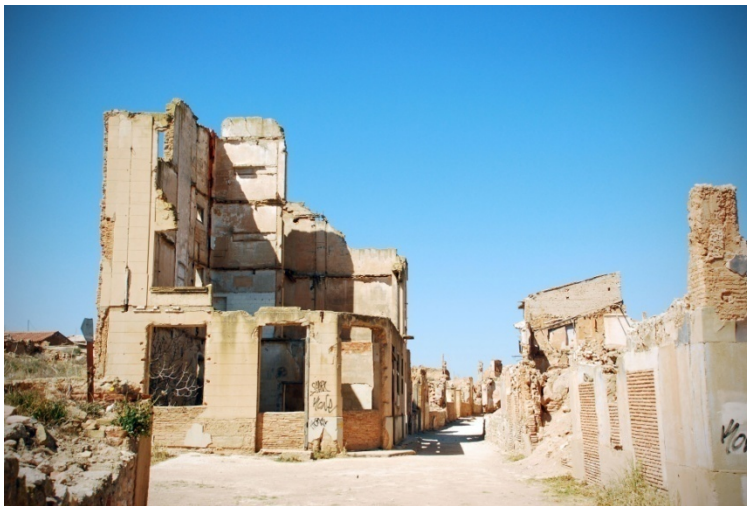
Edificio en ruinas, en una de las calles principales del pueblo Viejo de Belchite. (Antonio Becerrica Vidal, 2019)
