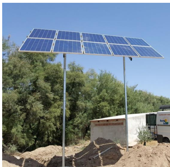
Figura 8: Ejemplo de instalación fotovoltaica aislada de red, para bombeo. Fuente Baena Solar
