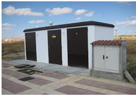
Ilustración 7. Centros de transformación
