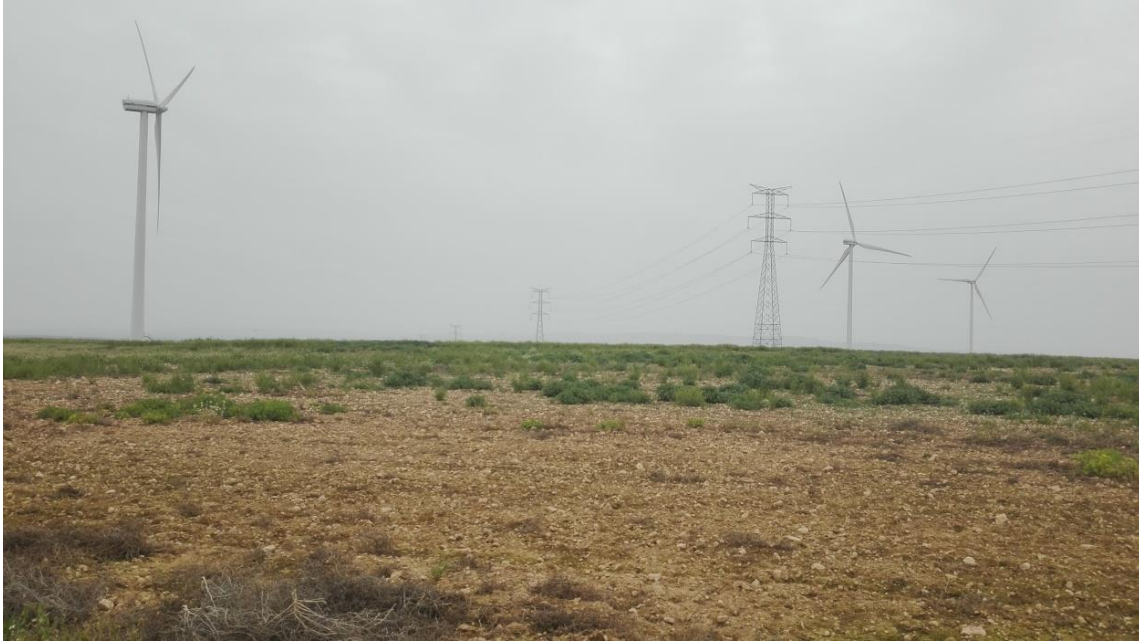
Figura 5: Parque eólico La Loba Fuente: elaboración propia
