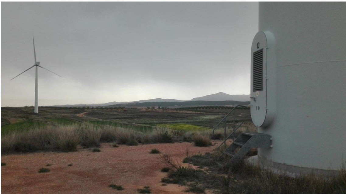
Figura 11: Parque eólico San Juan de Bargas Fuente: elaboración propia
