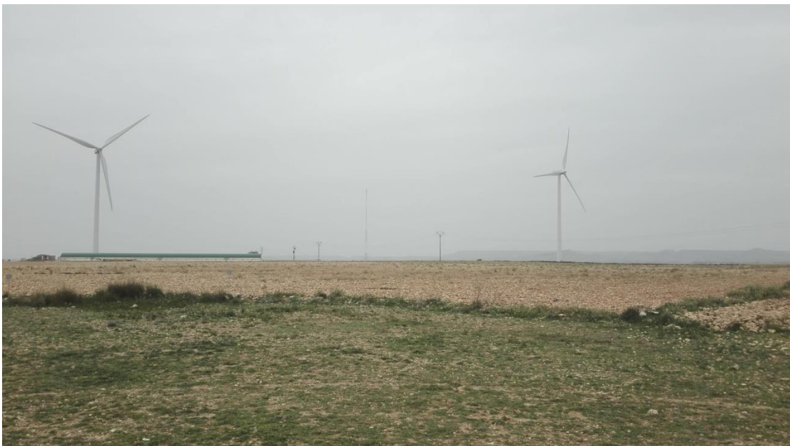
Figura 8: Parque eólico La Loba Fuente: elaboración propia
