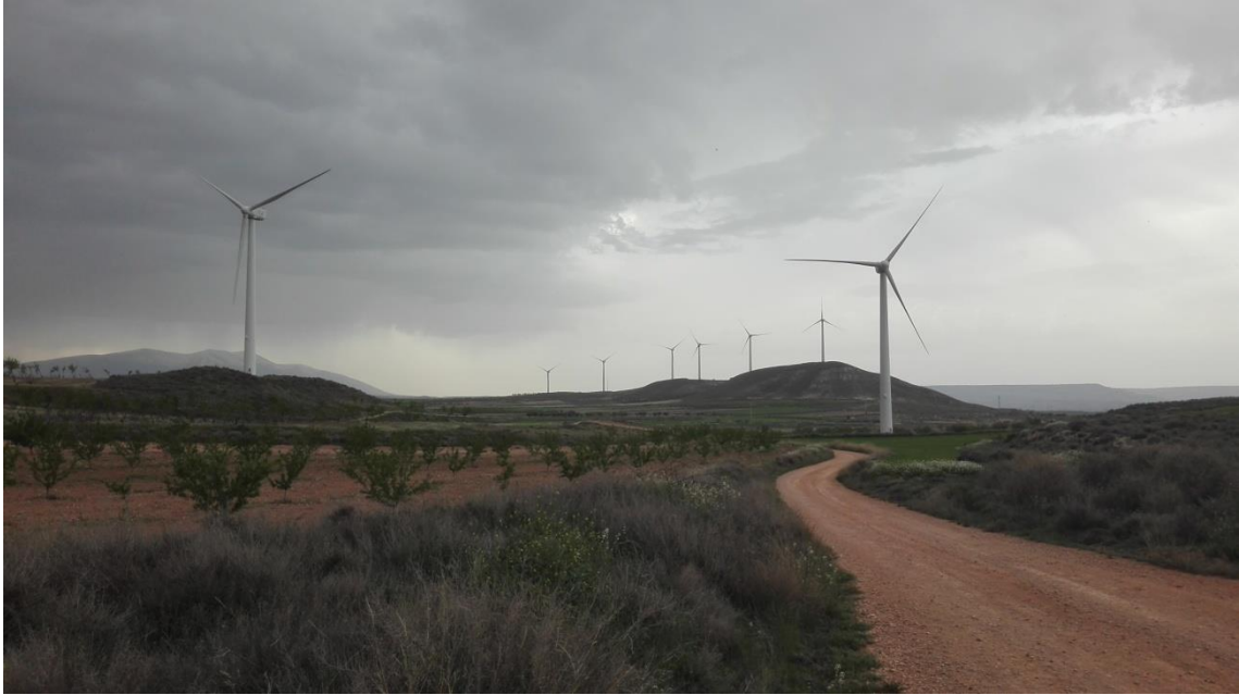
Figura 14: Parque eólico San Juan de Bargas Fuente: elaboración propia
