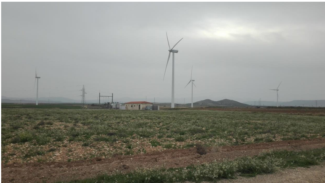
Figura 6: Parque eólico La Loba Fuente: elaboración propia
