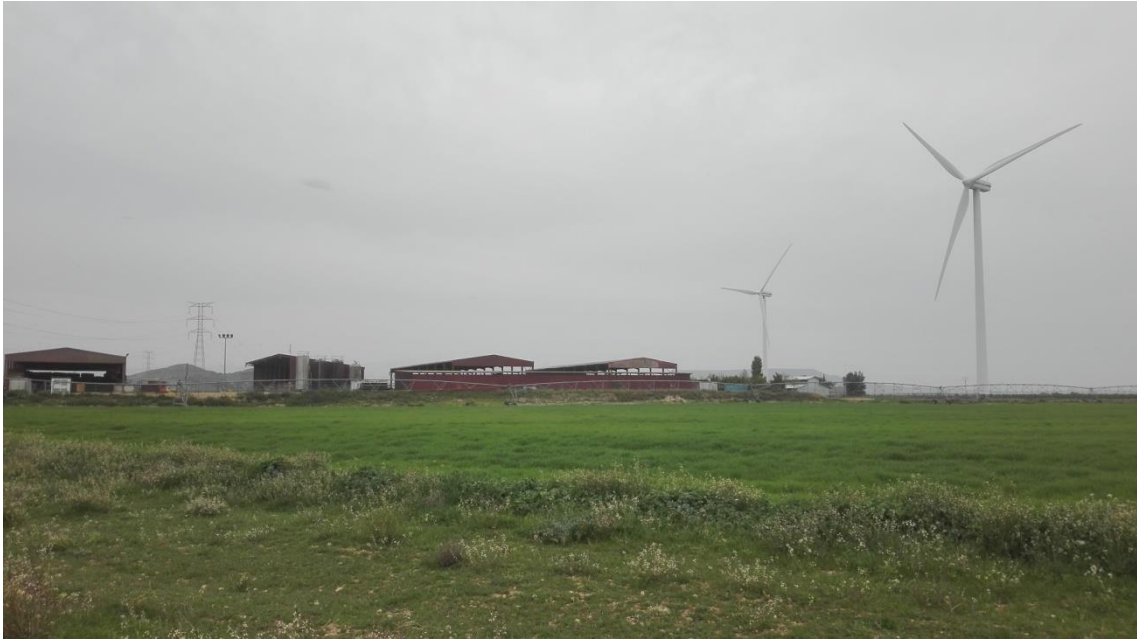
Figura 7: Parque eólico La Loba Fuente: elaboración propia
