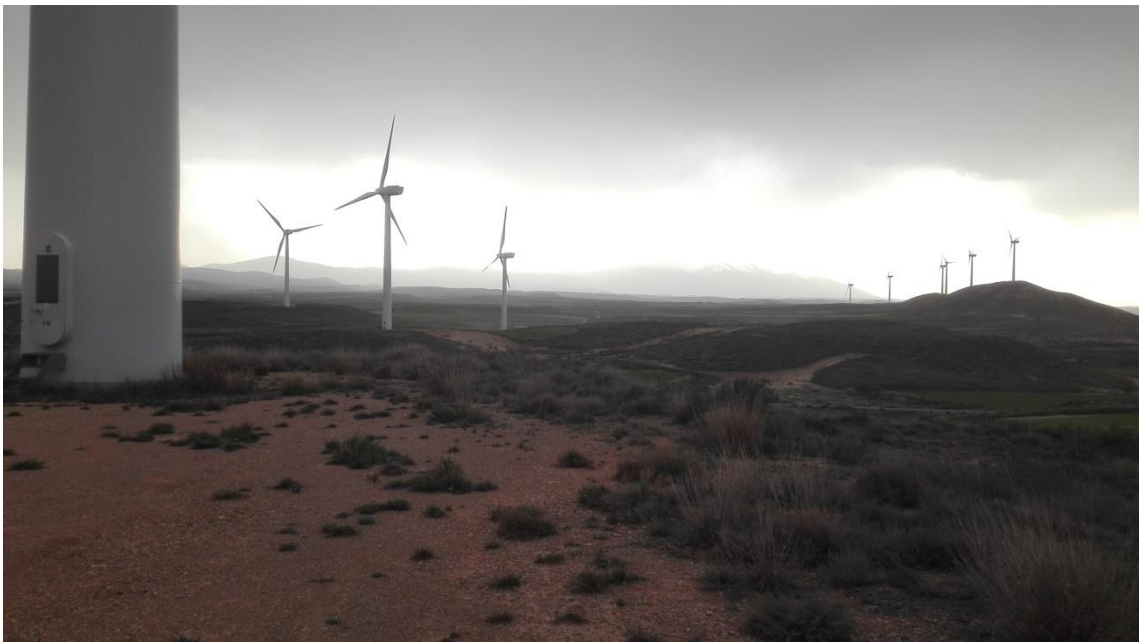
Figura 15: Parque eólico San Juan de Bargas Fuente: elaboración propia
