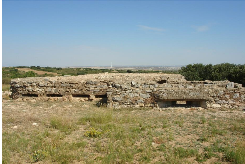
Imagen 18. Vestigio de la Guerra Civil española que se encuentra en el vértice de Parapetos (Zaragoza)
