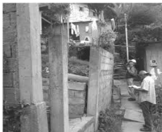
Fotografía 5.8 Viviendas asentadas en sitios de riesgo por deslizamientos y lluvias. Sector San José de Las Flores. Municipio Libertador. Estado Mérida.
