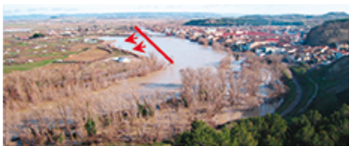
Fig. 4 – Élimination d'une digue en 2009 sur le fleuve Aragon à Caparroso et son effet positif durant la crue de janvier 2010
