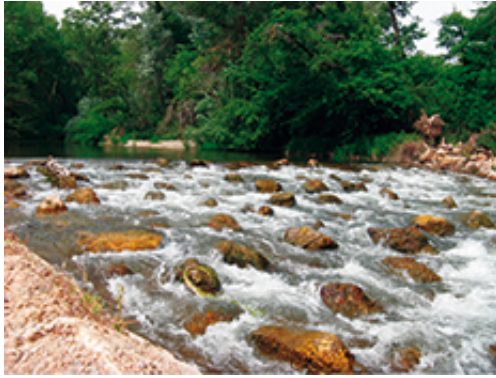
Fig. 8 – Rampe pour poissons dans le Najerilla (Torremontalbo, La Rioja)
