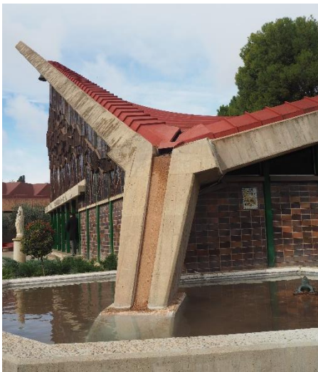
35. Apoyo de la cubierta de la Capilla. Fuente: Foto realizada por el autor.
