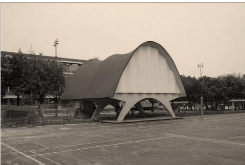
7. Pabellón de rayos cósmicos de Felix Candela, la lámina de hormigón que conforma su cubierta tan solo tiene 15 mm, permitiendo así el paso de los rayos cósmicos para la investigación. (1951, Ciudad de México). Fuente: Arquitectura y Empresa, disponible en: https://www.arquitecturayempresa.es/noticia/pabellon-de-rayos-cosmicos-1951-arquitectura-de-felix-candela
