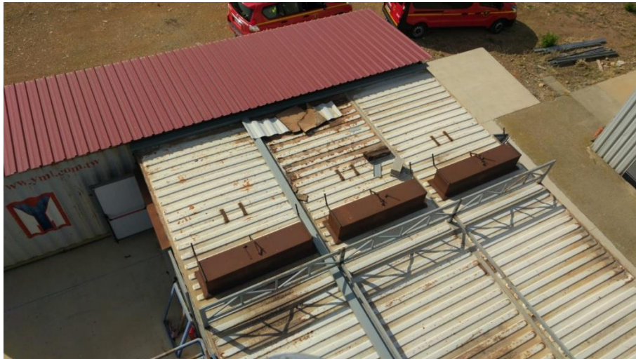
Ilustración 1: Instalación de entrenamiento situada en La Almunia
