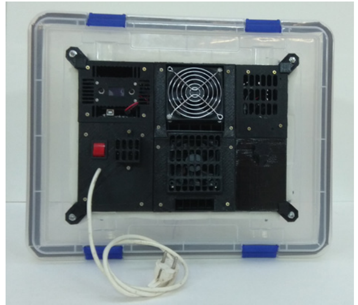
El controlador colocado en la tapa
