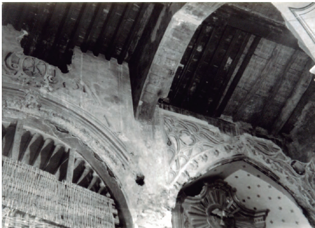
2. Proceso de la recuperación de la techumbre mudéjar en la iglesia de la Magdalena de Tarazona. Foto Archivo Tricas.
