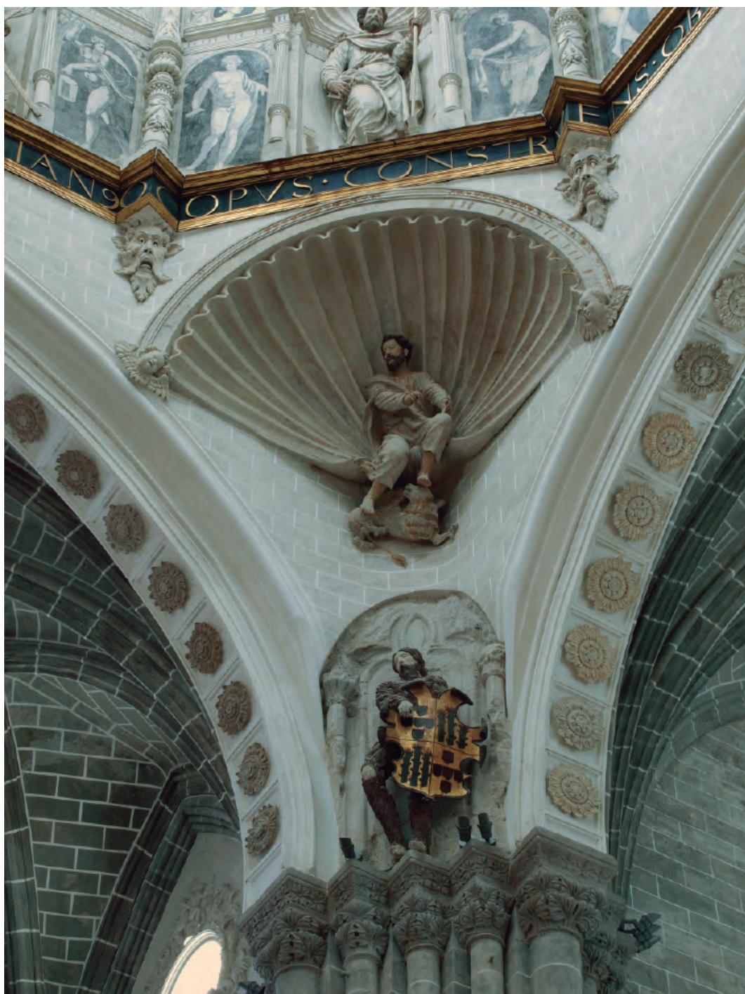
6. Detalle de una de las trompas del cimborrio. Catedral de N a S a de la Huerta de Tarazona. Foto José Latova, cortesía del Cabildo Catedralicio.
