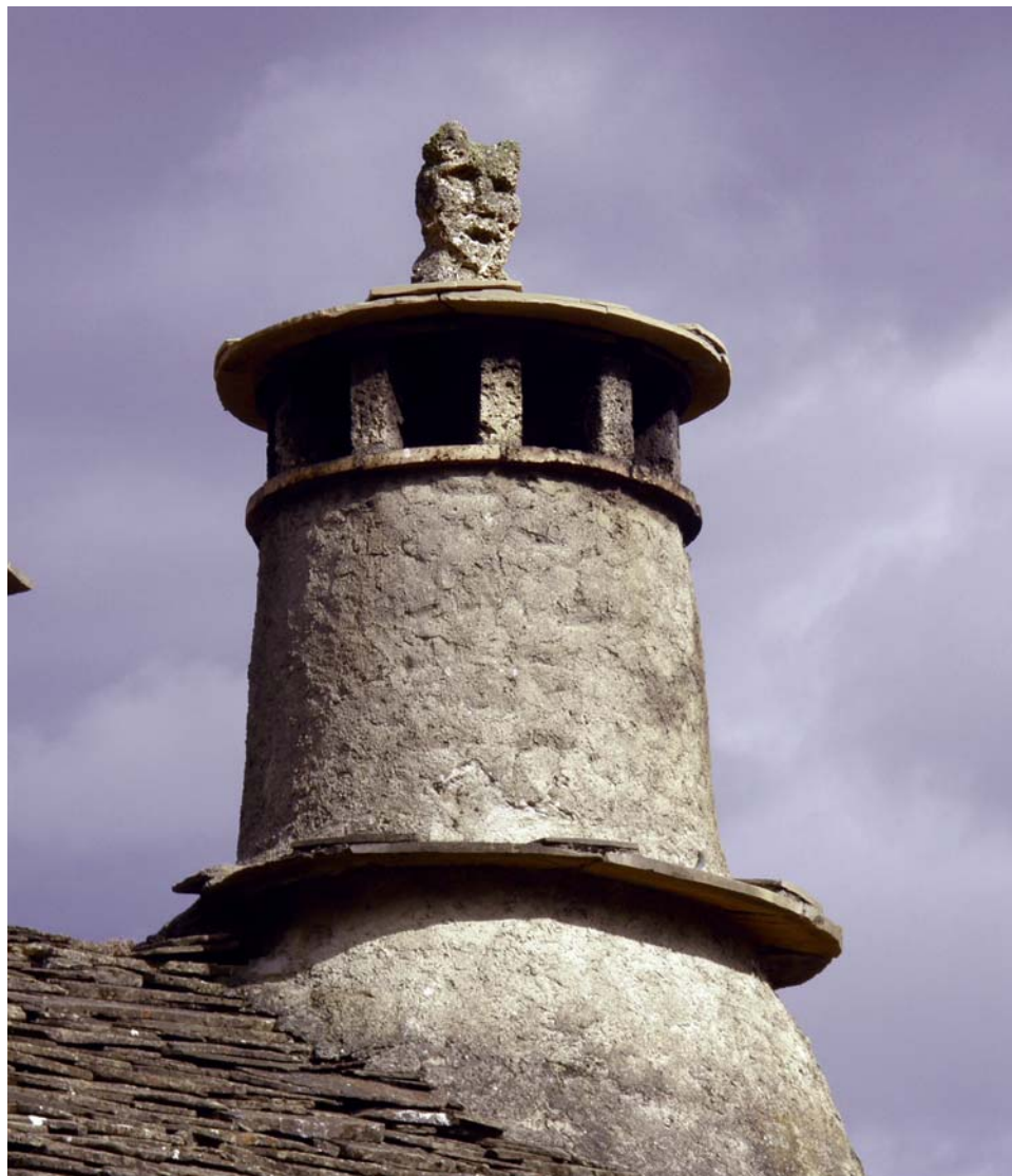
Fig. 1. Chimenea de tosca en Botaya.
