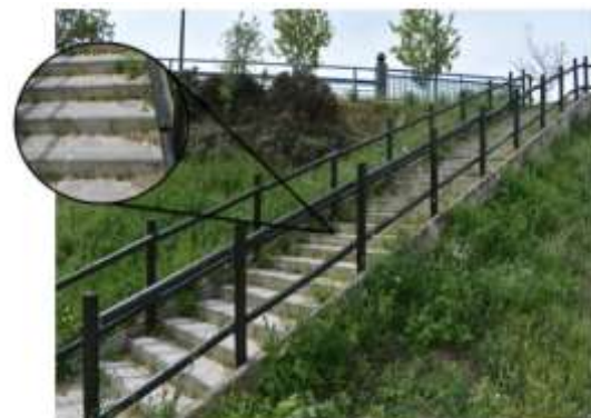
D) Superficie con escaleras
