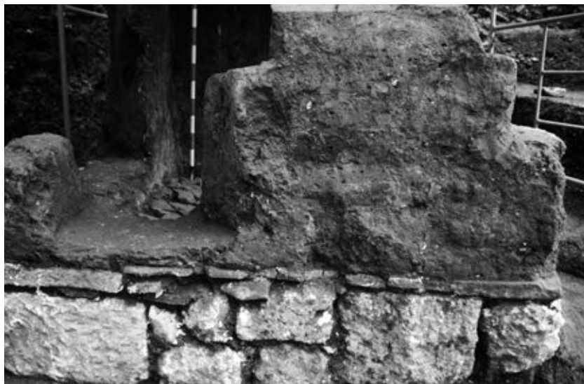
82. Lado occidental del edículo tras el levantamiento del enlucido. Zócalo de sillares. A la izquierda huella de la fosa islámica.
