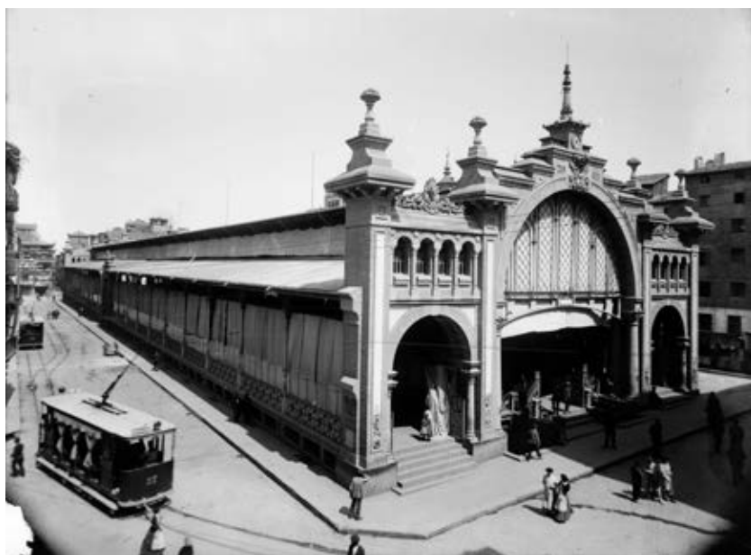
FOTO 6: Nuevo Mercado de Zaragoza. 1904. DGA, AHPZ, Archivo Coyne, cliché n.º 000023.
