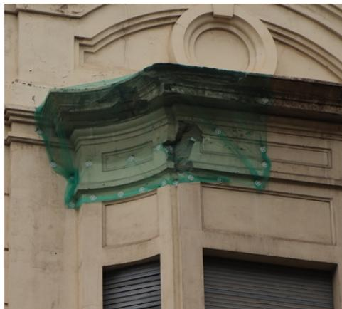
Fig. 7. Detalle del deterioro de una moldura en el inmueble
