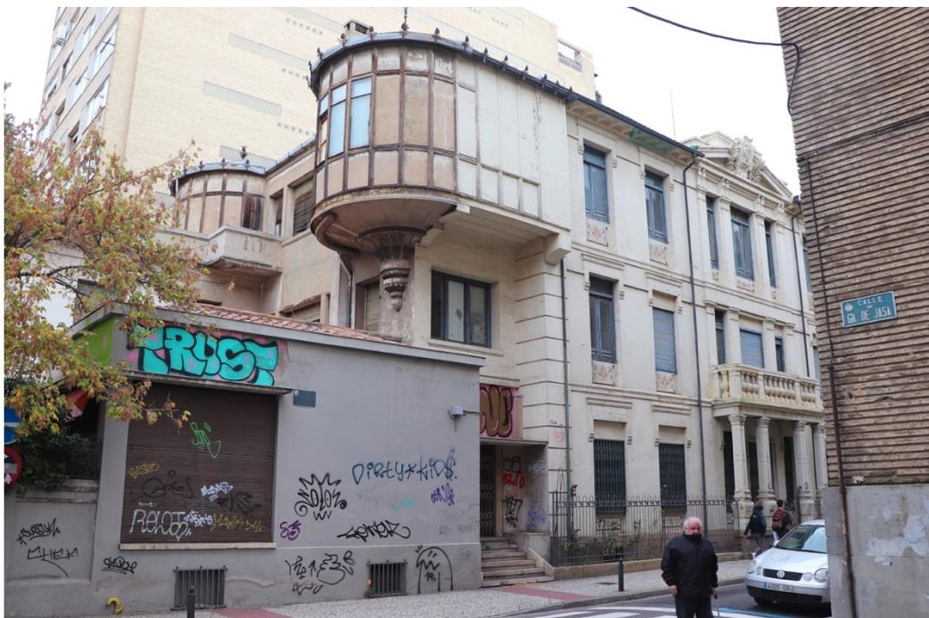
Fig. 8. Fachada oeste, donde se pueden ver los añadidos posteriores en un tono más oscuro, y parte de la fachada sur del edificio. Fotografía de la autora.
