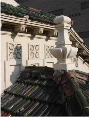
Fig. 4. Detalle del tejado del edificio, con las tejas de cerámica vidriada.
