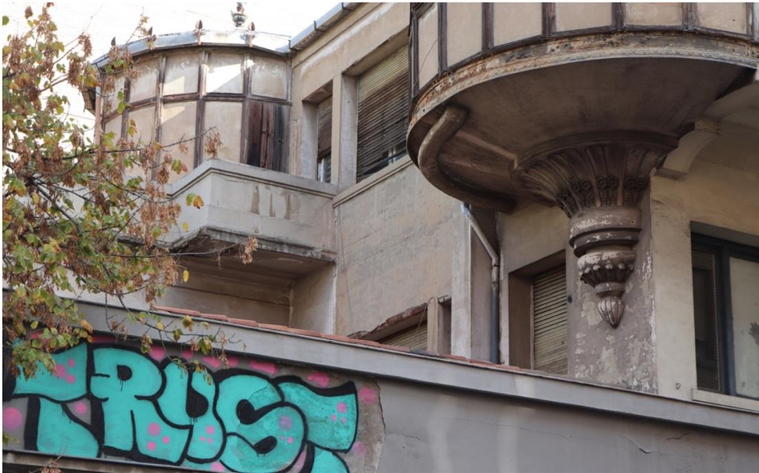
Fig. 9. Detalle de la fachada oeste, donde se aprecia el deterioro en la fachada y en la madera que conforma los miradores. Noviembre 2019. Fotografía de la autora.
