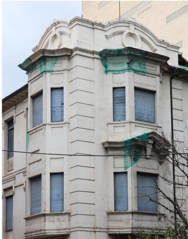
Fig. 7. Detalle de las molduras deterioradas en la fachada. Noviembre 2019. Fotografía de la autora.
