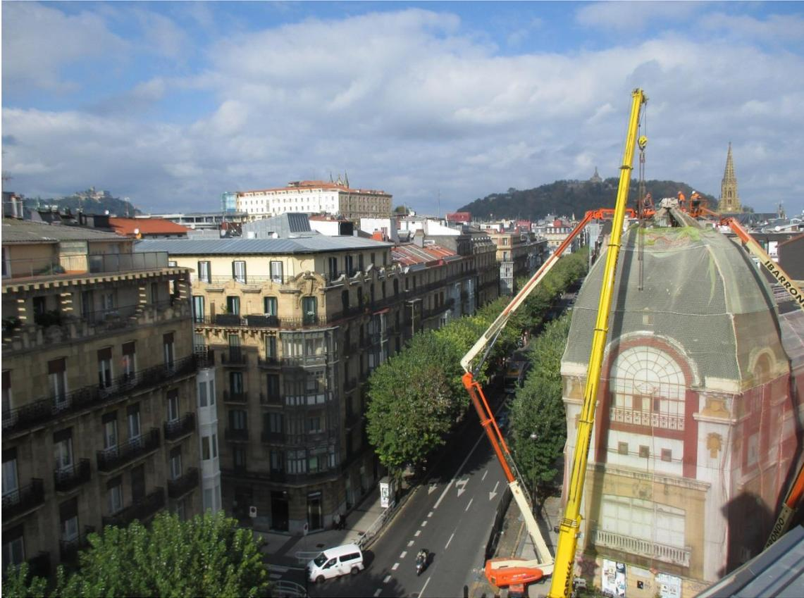
Ilustración 20. Imagen de la eliminación de la cúpula en 2015, fotografía personal
