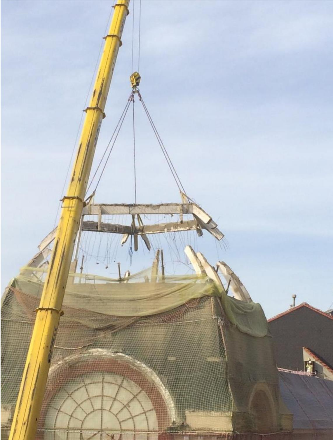
Ilustración 21. Fotografía de la eliminación de la cúpula, fotografía personal.
