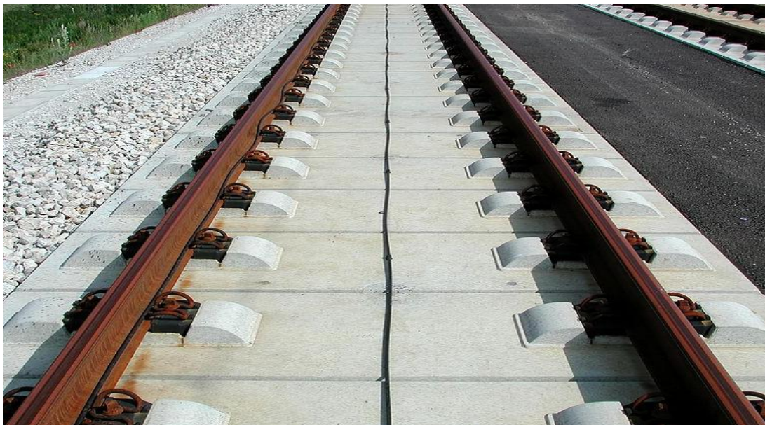
Figura 74. Sistema LZB. Baliza de control situada en el plano de la vía.
