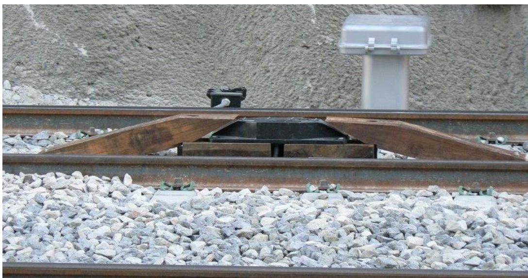
Figura 76. Sistema ASFA. Baliza de control situada en el plano de la vía.
