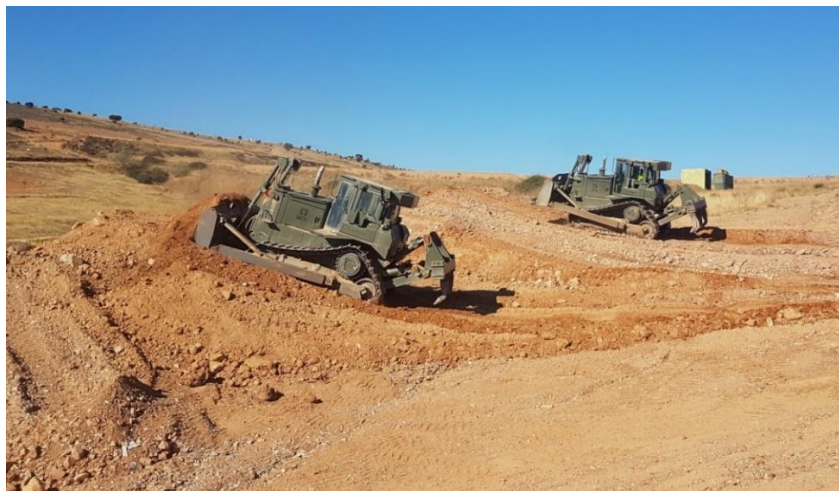
Figura 3. Empujadoras D7 del REI 11 trabajando en tándem para extraer material de cantera.
