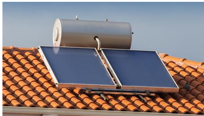
Figura 16 - Panel Solar Térmico (Fuente [18])
