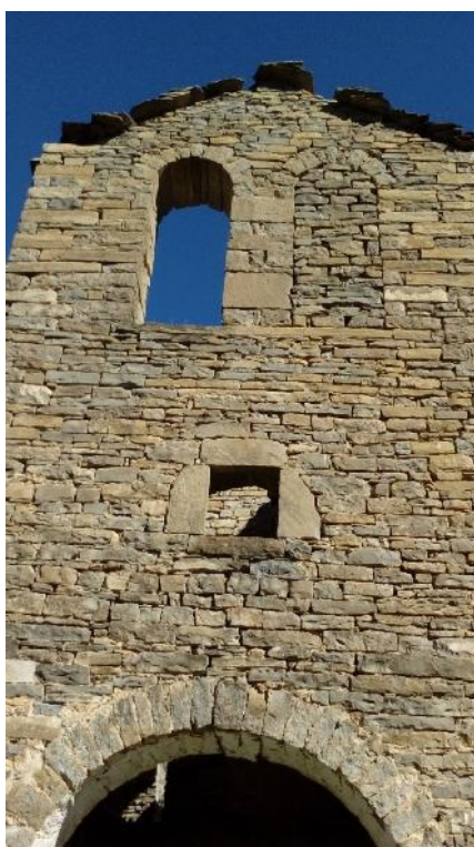
Fig. 20. Torre de la Iglesia de Ainielle
