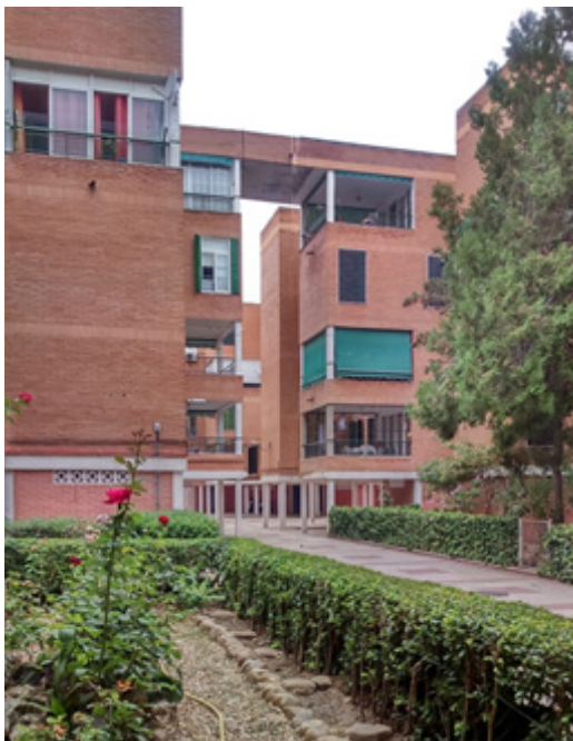
Figura 16: Viviendas en Torrejón de Ardoz, 1973-1977. Espacios intermedios en 2019 Fuente: Elaboración propia.
