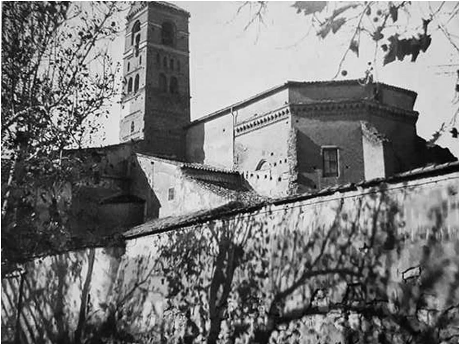
(Figura 11. Iglesia de San Francisco. Fotografía perteneciente a los archivos del C.E.B. Una de las iglesias más lloradas, hoy se sitúa en la plaza del mismo nombre, y de su estructura nos han llegado algunas fotos)
