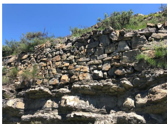
Figura 1: Detalle del muro de un bancal en San Vicente de Munilla.
