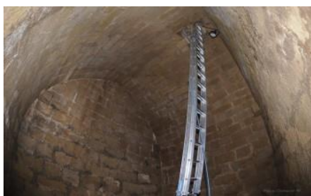
Fig.12. Interior del pozo. (Actualidad)
