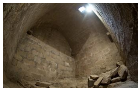
Fig.13. Interior del pozo. (Actualidad)
