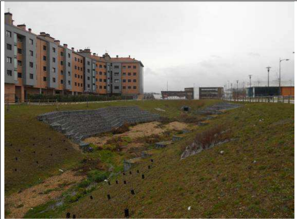
Figura 36: Ensanchamiento para laminación en el Ali, en Zabalgana (Febrero 2012)
