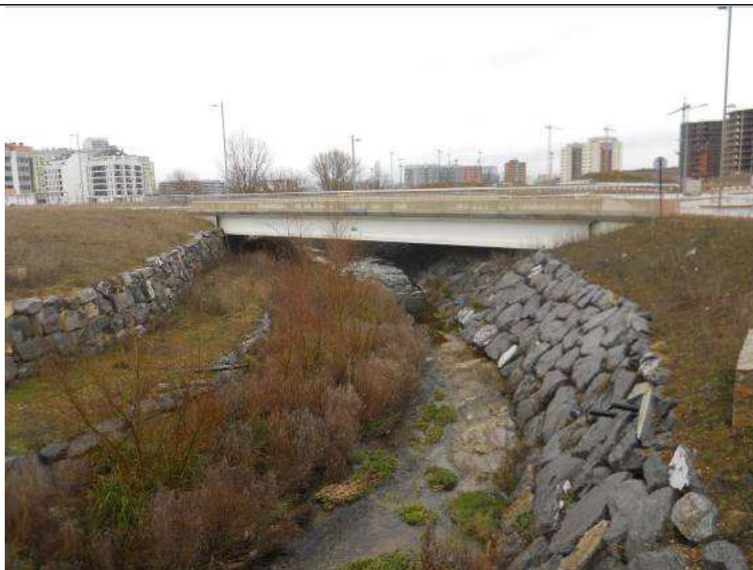
Figura 43: Escolleras en el Errekaleor (Febrero 2012)
