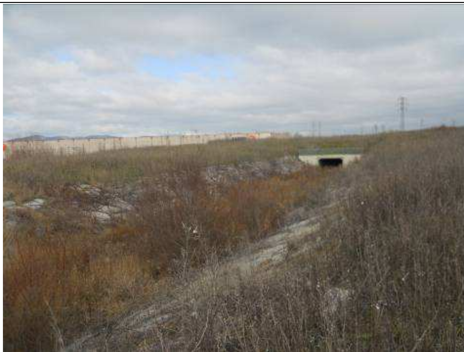
Figura 41: Balsa de laminación en el Torroguico justo antes de embocinarse (Febrero 2012)
