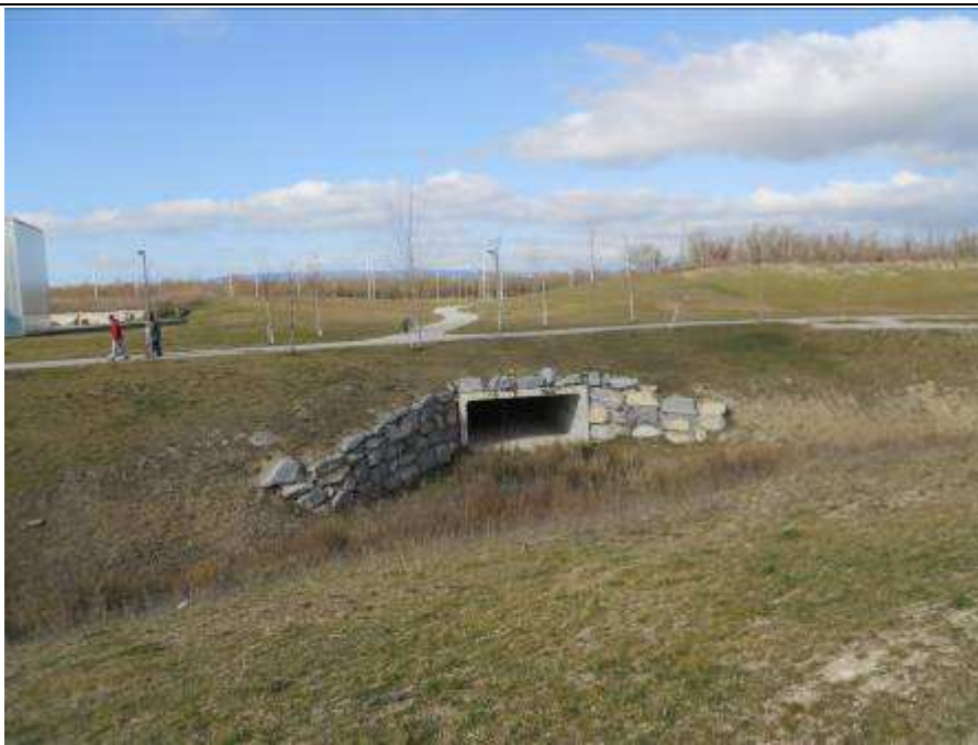
Figura 39: Laguna de laminación en el Zarauna y toma de la derivación a las lagunas de Zabalgana (Febrero 2012)
