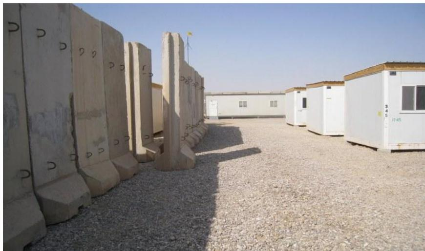
Figura 7. Muro de T-Wall en una base española
