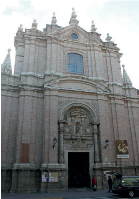
Figura 20. Fachada de la iglesia del antiguo colegio de la Compañía de Jesús de Calatayud, actual de San Juan el Real. Foto: autora.
