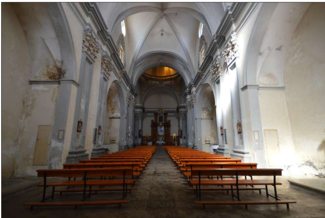
Fig. 2. Azuara (Zaragoza). Iglesia de la Piedad, interior. Foto autor.
