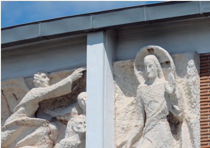
Fig. 10. Fragmento del tercer y cuarto panel del friso de la Glorificación del martirio en la iglesia del teologado de los dominicos en Alcobendas (Madrid). Miguel Fisac arquitecto; Susana C. Polac, escultora. Fotografía Eduardo Delgado Orusco, 2019.
