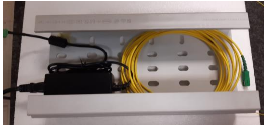
Figura 26: Colocación de cableado en la canaleta.
