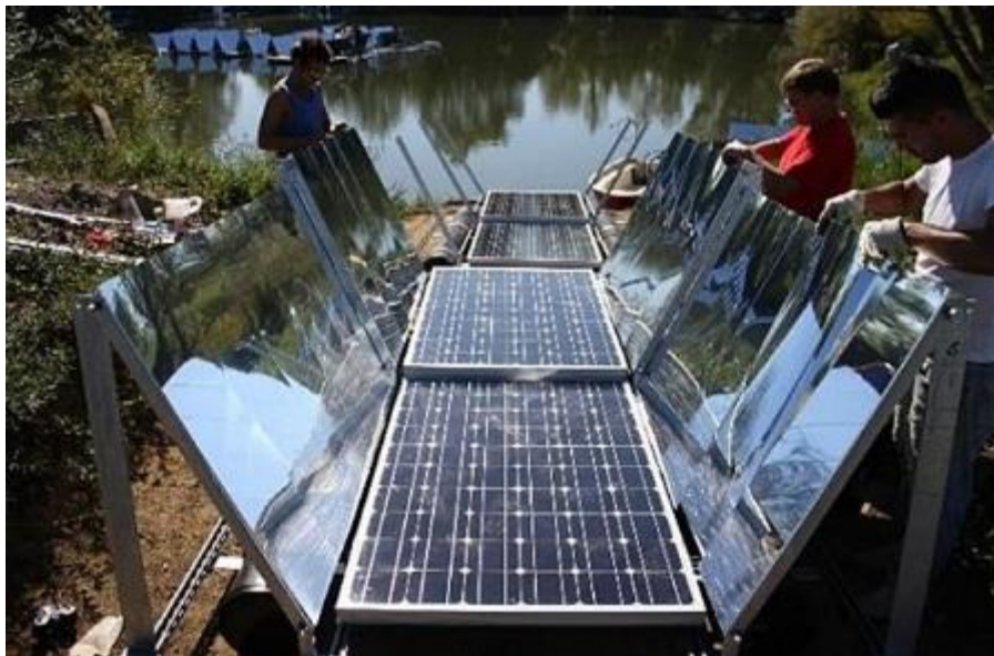
Fig 6. Foto del montaje de los espejos y paneles desarrollados por el grupo Scintec. Fuente: [32].
